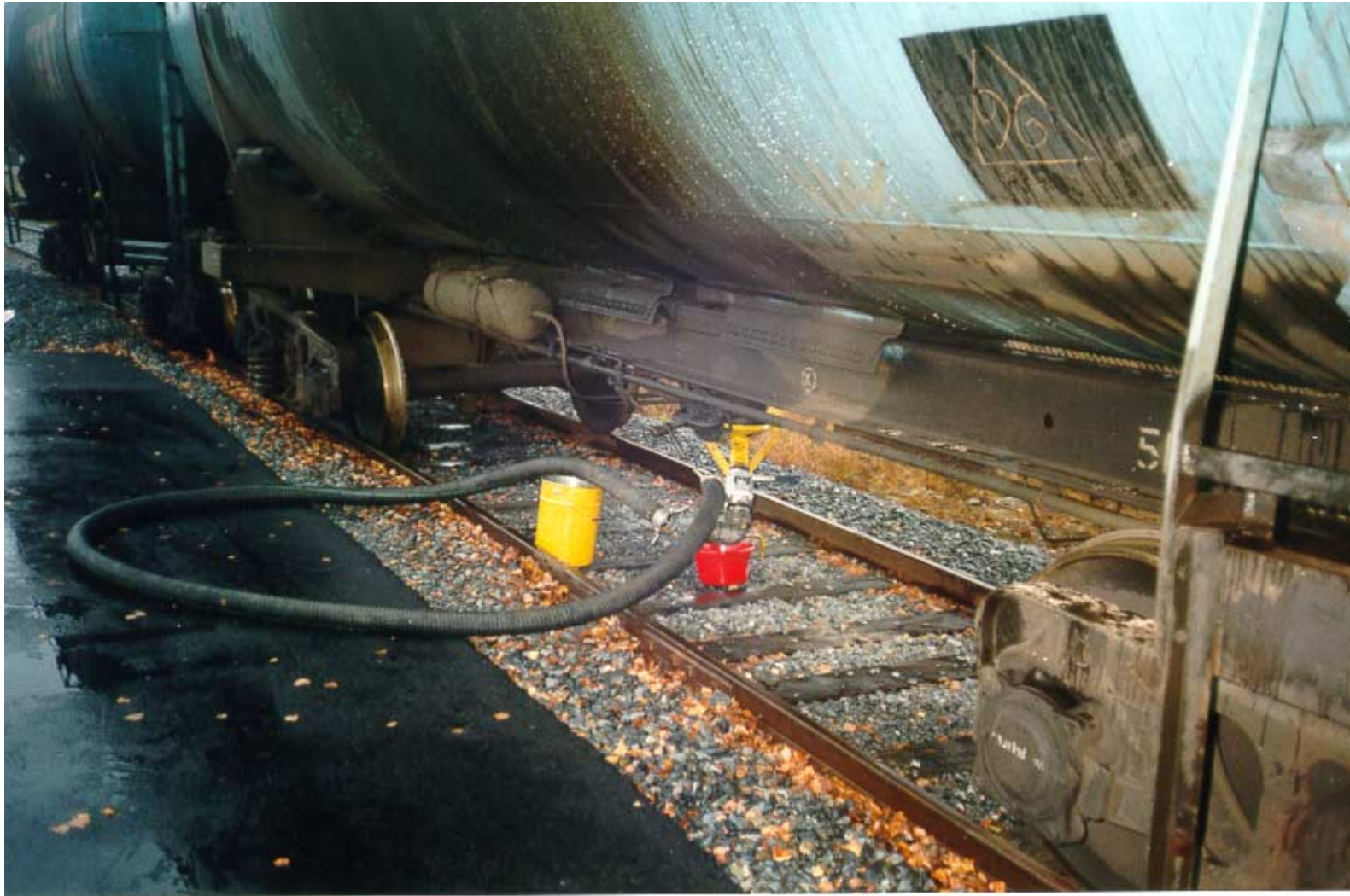
Kuva 10. Öljyvaunun tyhjennysletku alatyhjennysliittimessä.
