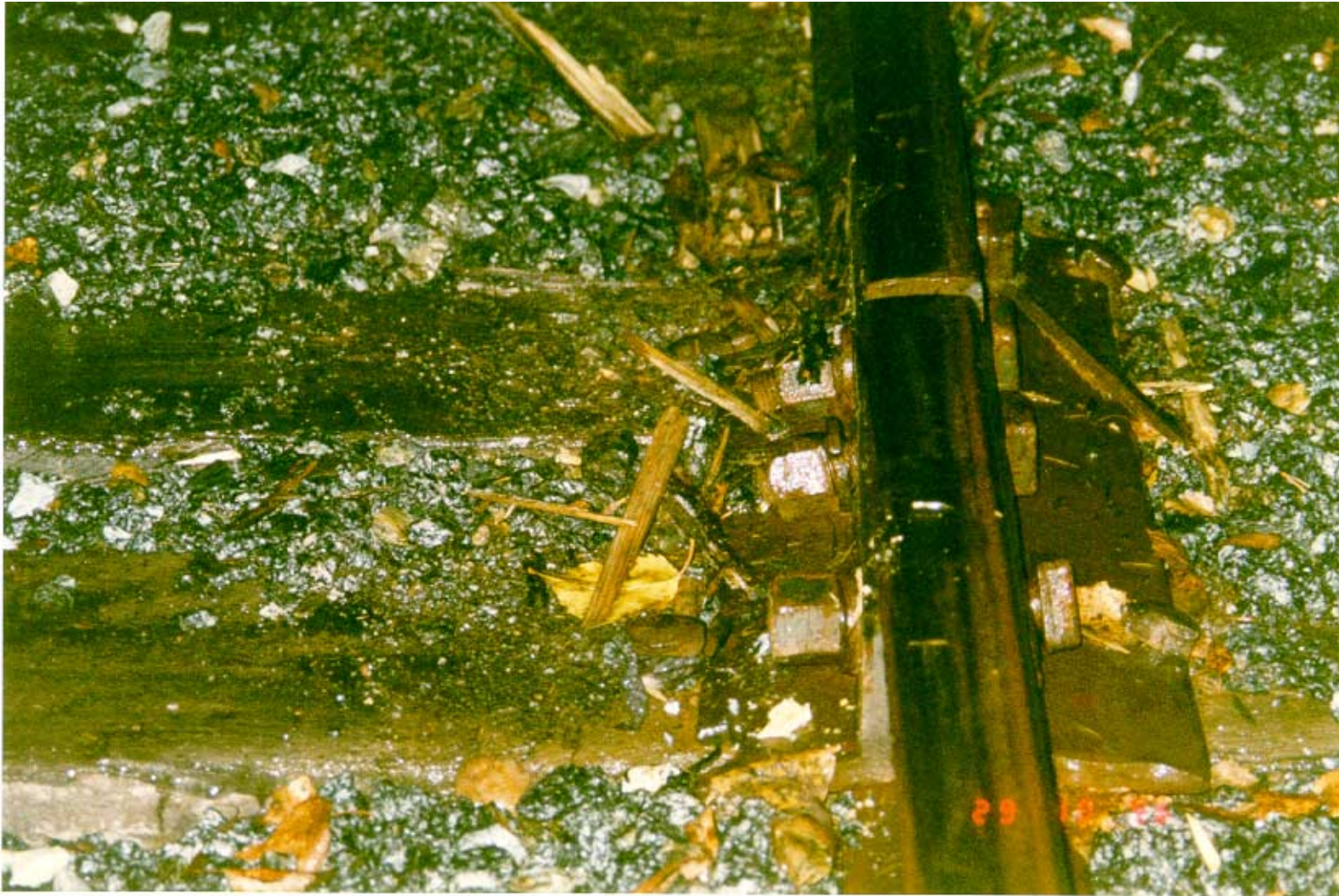
Kuva 5. Jatkos, josta suistuminen alkanut; oikea kisko.
