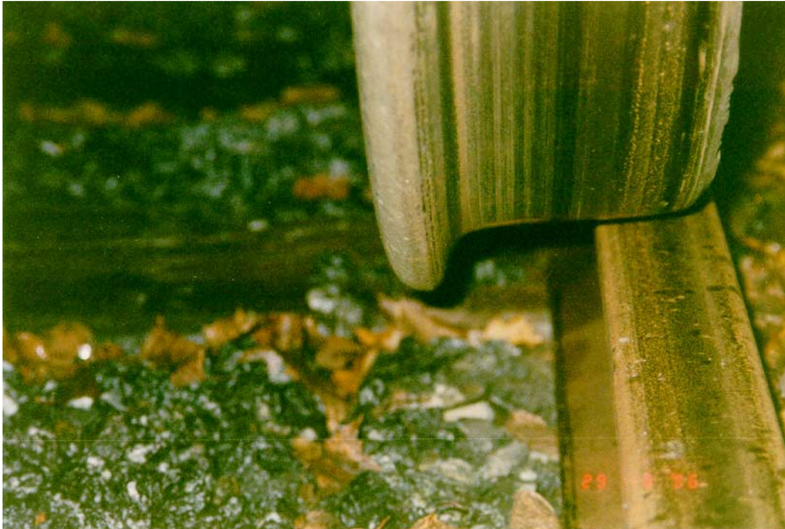
Kuva 9. Toiseksi takimmaisen öljyvaunun (51962330:n) takimmaisen pyöräkerran oikea pyörä, edellisessä kuvassa (kuvassa 8) olevan pyörän pari. Pyörä on kiskoon nähden liiksi sisäpuolella. Kiskot ovat 40mm sallittua leveämmällä. Mittavertailuna: pyörän leveys on 130 mm.
