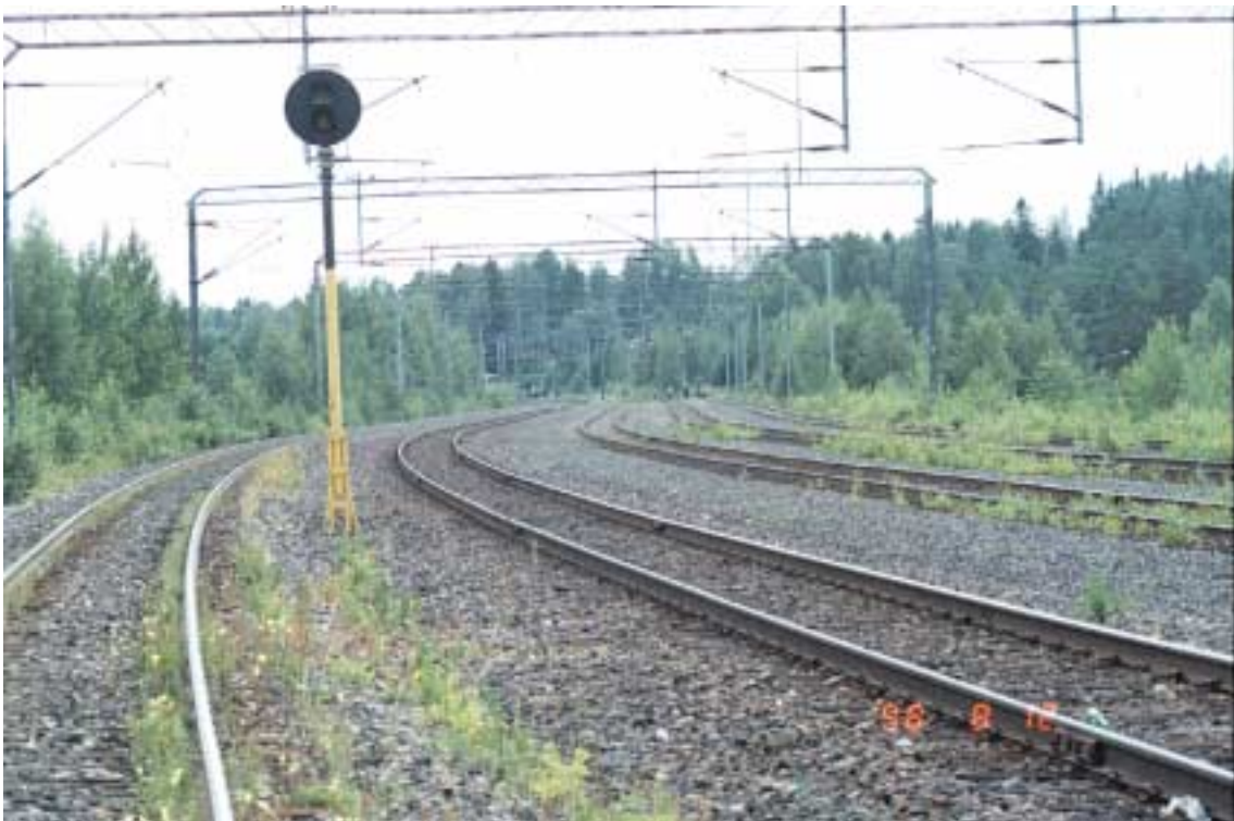
Kuva 8. Junien yhteentörmäys Suonenjoella 12.8.1998. Suonenjoen aseman eteläpuolella on opastinjärjestelmään kuulumaton kertaaja, jonka tarkoituksena on ilmaista taustalla näkyvän lähtösuunnan pääopastimen opaste. Tutkimuksissa ilmeni, että kertaaja on voinut toimia virheellisesti, mutta pääopastin näytti matkustajajunalle punaista "seis"-opastetta.
