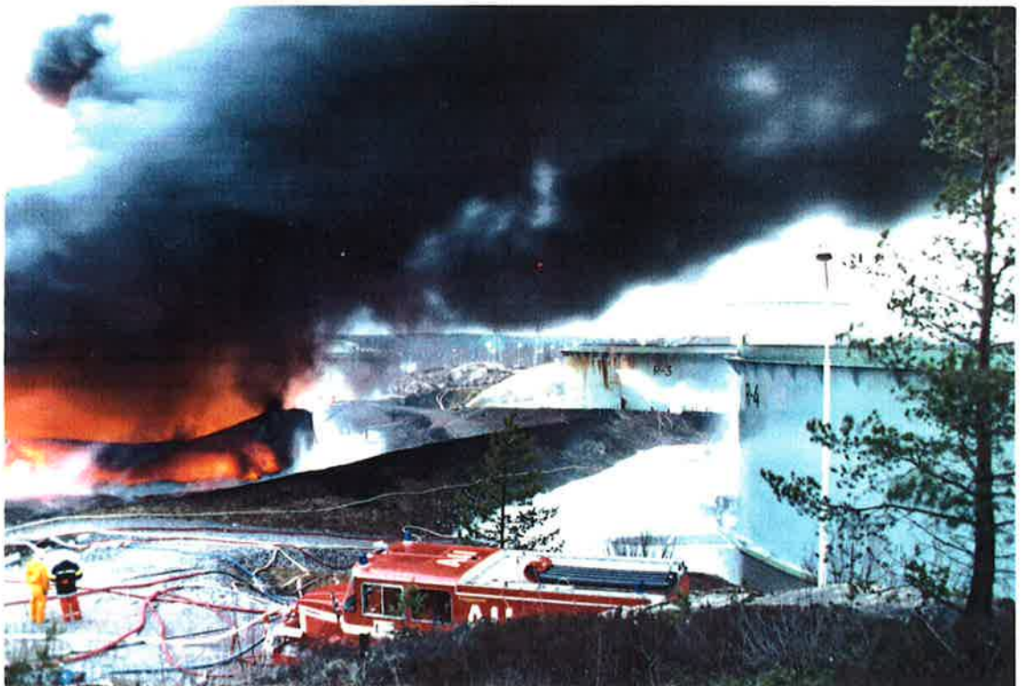
KUVA 9. Tulipalon loppuvaihe. Säiliö R-2 on punahehkuisena ja sen yläosa on taipunut sisäänpäin. Naapuri-säiliöiden suojaustoimenpiteet ovat käynnissä.
