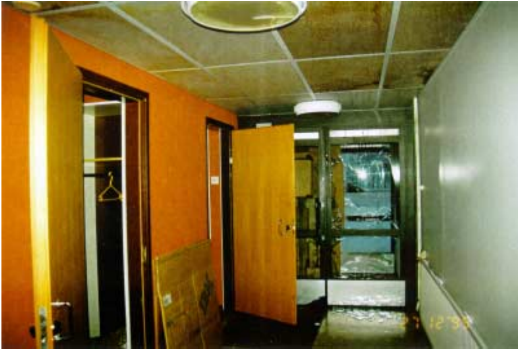
Uuden majoitusosan alakerran käytävä ei vaurioitunut palossa. Taustalla on uuden majoitusosan ulko-ovi, jonka lasit rikottiin pelastustyön aikana.
