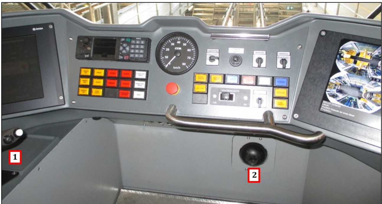
Kuva 15. Smart Artic X54-raitiovaunun ohjaamon ohjauspöydän ja jalkatilan laitteet. Kuvassa numero 1 on ajokahva ja numero 2 on turvalaitteen jalalla painettava painike. (Kuva: OTKES)
