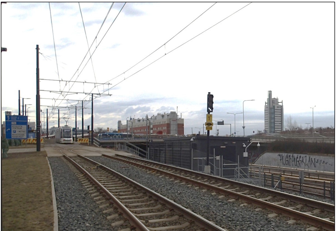
Kuva 12. Saapuminen Itäkeskuksen päätepysäkille. Kuvassa betonikannella sijaitsevat vaihteet ohjaavat pysäkille oikeanpuoleista raidetta saapuvan vaunun kulkusuunnassa vasemmalle raiteelle. Opastimen alimmissa aukossa näkyvä vasemmalle kallistunut viiva ilmaisee vaihteen asennon. (Kuva: OTKES)
