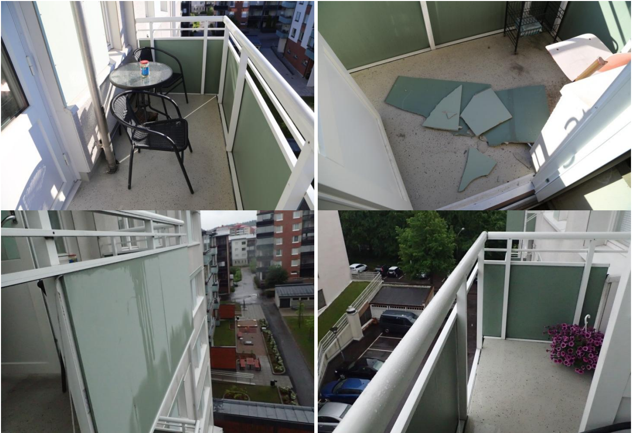
Kuva 2. Kuvia onnettomuusparvekkeesta sekä oikeassa yläkulmassa alemmalle parvekkeelle pudonneita levyn paloja. (Kuvat: Yläriivi poliisi, alarivi OTKES)
