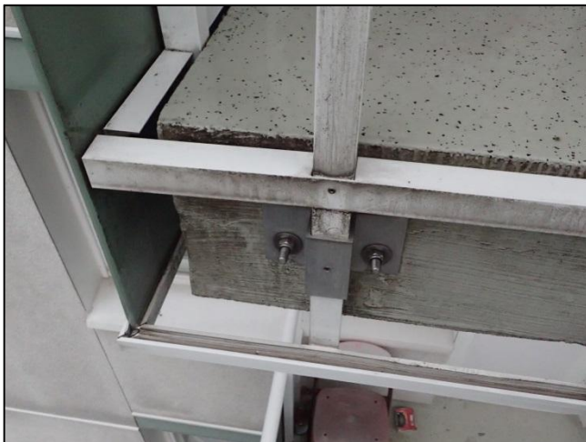
Kuva 5. Parvekelevyn alareunan kiinnitystapa alumiiniseen parvekekaiteen runkorakenteeseen. (Kuva: OTKES)
