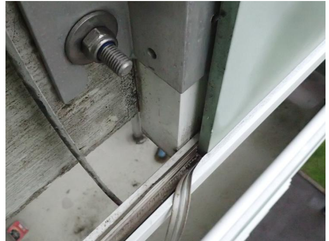
Kuva 5. Parvekelevyn alareunan kiinnitystapa alumiiniseen parvekekaiteen runkorakenteeseen. (Kuva: OTKES)
