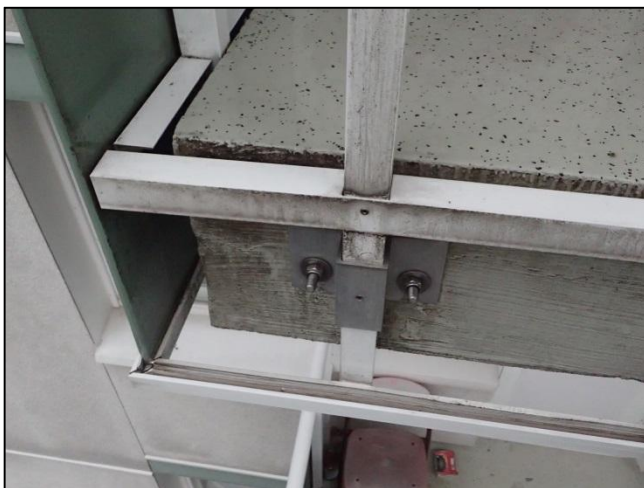
Bild 5. Fästmetod för hur balkongskivans nedre kant är fäst vid balkongräckets stomkonstruktion i aluminium. (Bild: OTKES)
