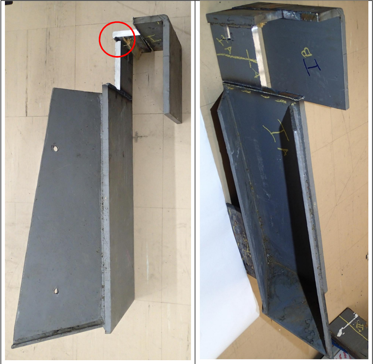
Kuva 5. Onnettomuudessa pettänyt toinen palkkikengä myöhemmin kuvattuna. Kengästä on leikattu paloja hitsausliitosten tutkintaa varten. Vaurioitunut hitsi palkkikengän yläosassa on ympyröity kuvaan. Primääripalkin paikka näkyy hyvin vasemmassa kuvassa ja sekundääripalkin "tasku" oikeassa kuvassa. Kengän korkeus oli noin 750 mm. (Kuva: OTKES)
