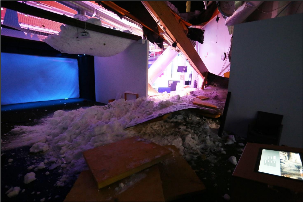
Kuva 2. Simulaattori-leikkipaikka sortuman jälkeen. Suojaverkko kesti sen päälle pudonneen lumimassan. (Kuva: poliisi)
