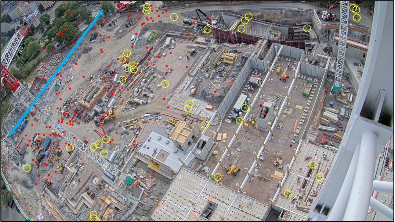
Kuva 2. Onnettomuushetki. Räjähdyspaikka näkyy kuvan vasemmassa alareunassa. Työmaalle sinkoutuvien kivien osumat on merkitty punaisilla pisteillä ja työntekijät keltaisin ympyröin. Sinisen viivan vasemmalle puolelle merkityt kivet lentävät ilmassa (Kuva: työmaakamera, merkinnät OTKES)
