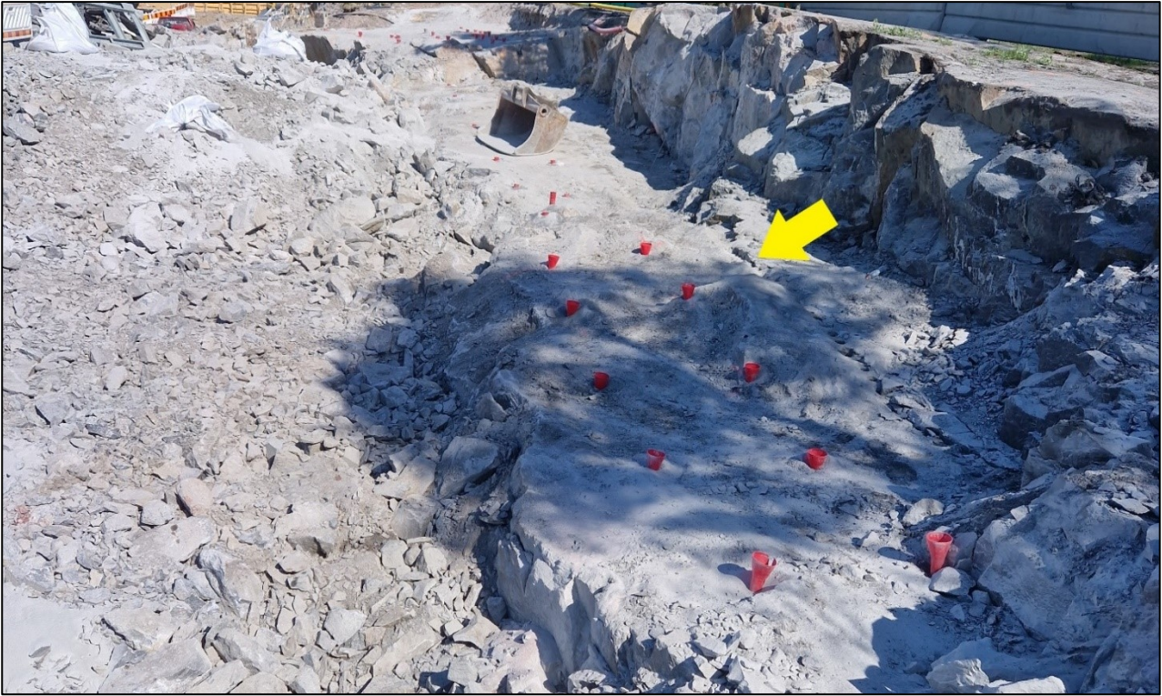
Kuva 3. Kuva kentästä ennen panostusta. Räjätys suunnitelman mukaan panostettavat reiät ovat merkitty punaisiin suppiloin. Keltainen nuoli osoittaa harvareikäirtiporauslinjaa, johon räjähteitä oli joutunut suunnittelemattomasti. (Kuva: Jari Honkanen)
