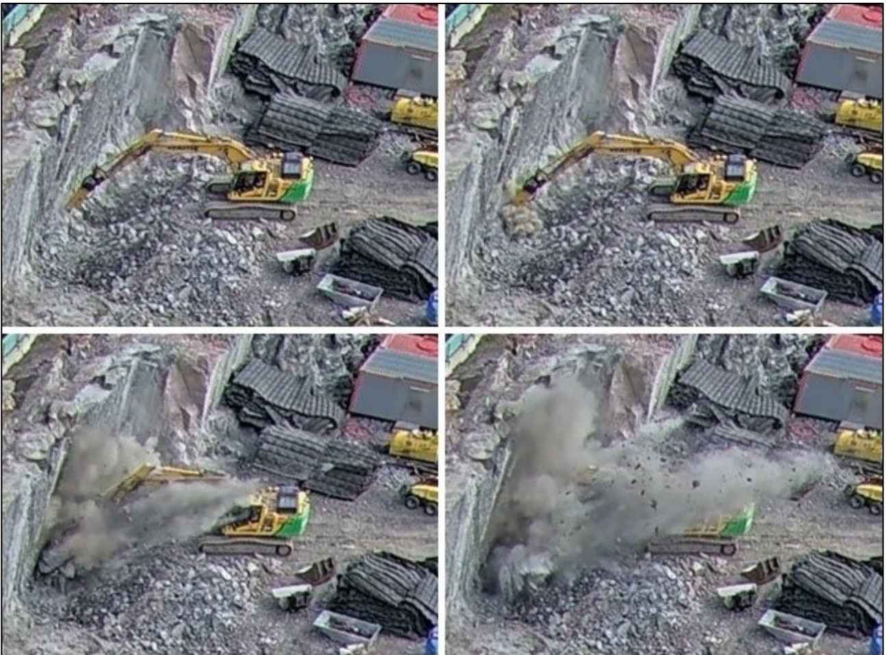
Kuva 1. Kuvasarja räjähdyshetkestä ja siinä sinkoavista kivistä. (Kuvat: työmaakamera)
