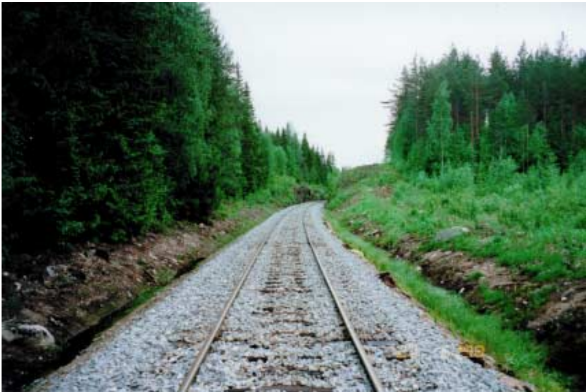
Kuva 3. Kahden ratakuorma-auton yhteentörmäys Vesangalla 23.6.1998. Kuva Tka 217 ajosuunnasta kallionleikkaukseen, missä Tka 142 seiso.
