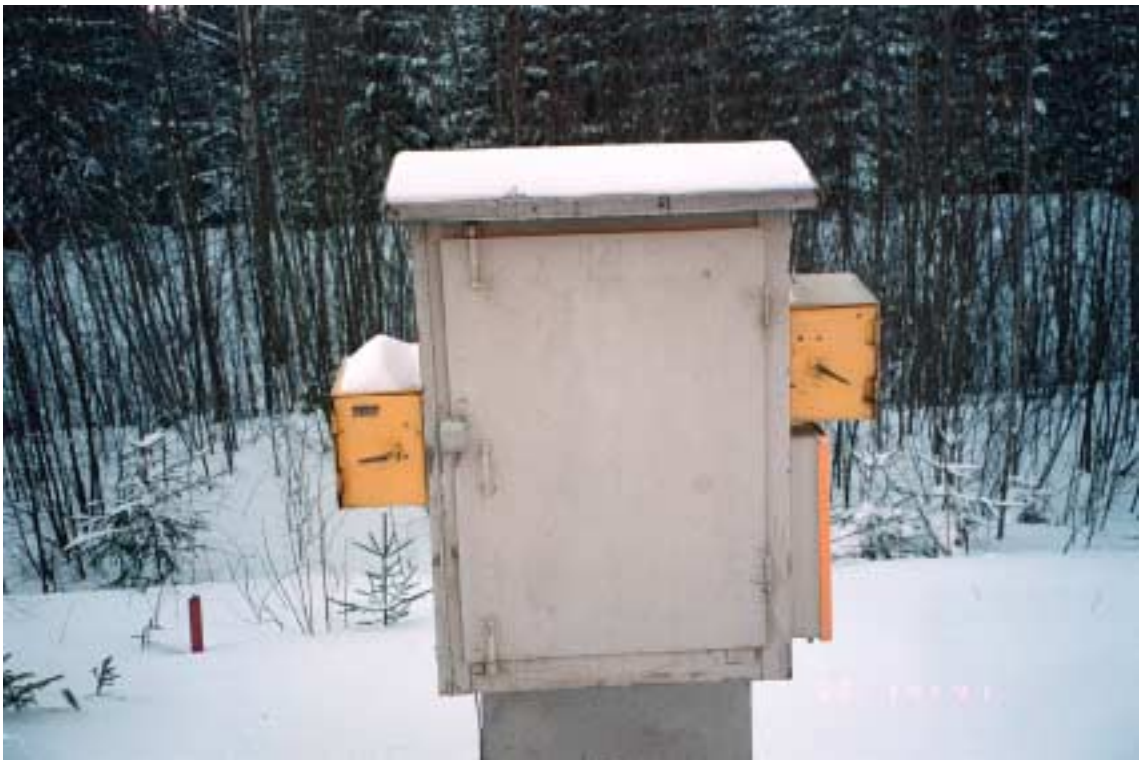
Kuva 3. Henkilövaunun suistuminen kiskoilta Mynttilässä 30.1.1999. Vasemmanpuoleisessa kotelossa on vaihteen V2 ja vaihteen V4 a/b-pään kääntö- sekä "Valmis"-painikkeet. Oikeanpuoleisessa (vaihteen V2 puoleisessa) kotelossa on vaihteen V4 c/d-pään kääntö- sekä "Valmis"-painikkeet.
