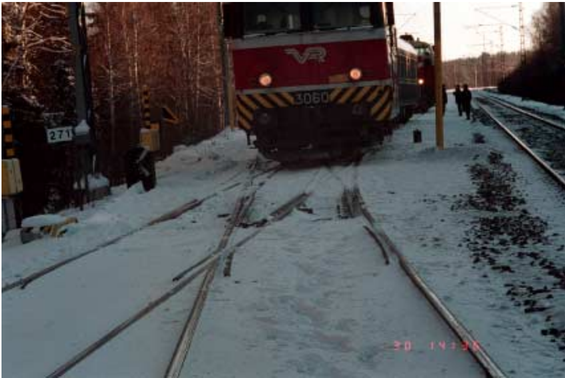
Kuva 6. Henkilövaunun suistuminen kiskoilta Mynttilässä 30.1.1999. Keskellä kuvaa katkennut vaihteen kieli.
