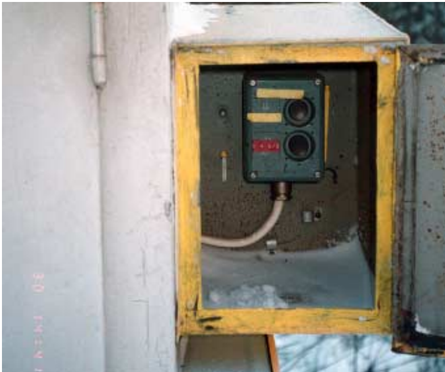
Kuva 5. Henkilövaunun suistuminen kiskoilta Mynttilässä 30.1.1999. Oikeanpuoleinen kotelo, jossa painikkeet "V4 c/d" ja "Valmis".
