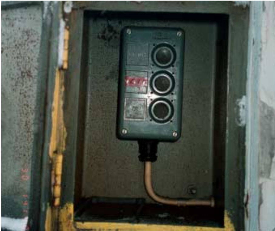
Kuva 4. Henkilövaunun suistuminen kiskoilta Mynttilässä 30.1.1999. Vasemmanpuoleinen kotelo, jossa painikkeet "V2", "V4 a/b" ja "Valmis".
