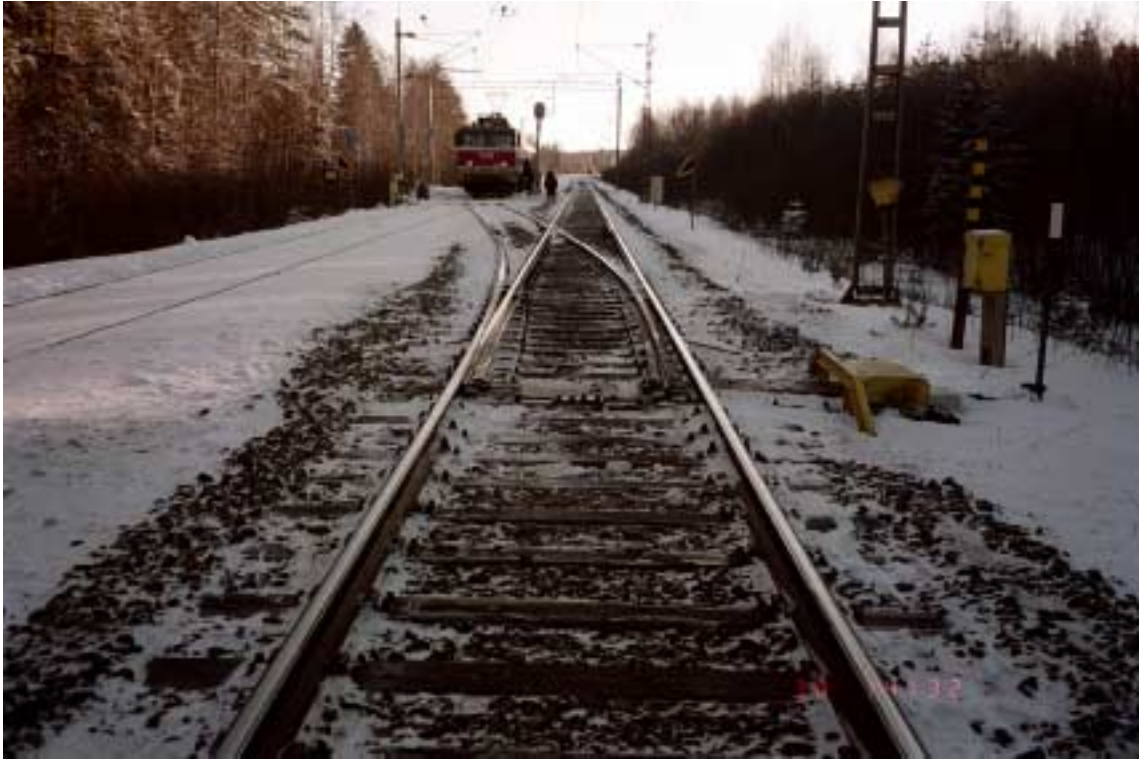
Kuva 2. Henkilövaunun suistuminen kiskoilta Mynttilässä 30.1.1999. Yleiskuva vaihteelta V2 katsottuna. Noin veturin keulan kohdalla raiteen oikealla puolella olevan kaapin sivuilla on paikalliskääntöpainikekotelot.
