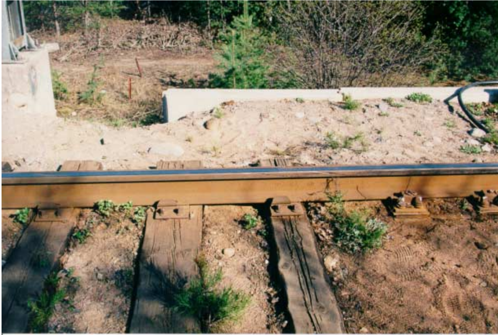
Kuva 1. Suistumisen alkamiskohta. Seitsemäntenä (toiseksi viimeisenä) olleen lasikuormatun venäläisen tavaravaunun takateli putosi kiskoilta juuri viimeisen puuratapölkyn kohdalla ennen sillan kantta. Koska veturinkuljettaja ei huomannut suistumista, suistunut vaunu kulki vielä yli koko sillan ja suitui sen jälkeen alas ratapenkereeltä. Kuvassa on nähtävissä myös kiskon erilainen kiinnitys puuratapölkkyyn ja sillan betoniseen maatukeen.
