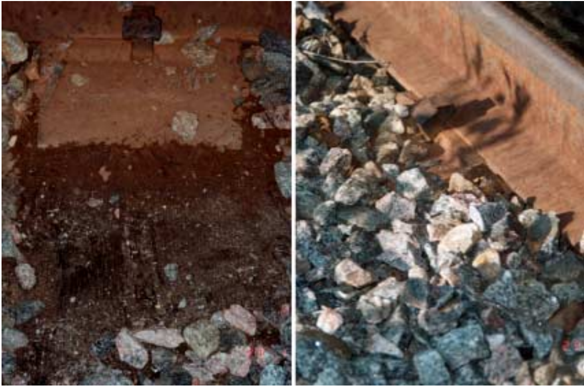
Kuva 4. Viiden puutavaravaunun suistuminen Saaren liikennepaikalla 29.6.2000. Onnettomuus tapahtui raiteella 3, jolla oli naulakiinnitteiset K30-lyhytkiskot. Suistumiskohta oli kaarteessa, jonka ulomman kiskon aluslevyt olivat siirtyneet. Merkinä aluslevyjen ja kiskon siirtymisestä olivat myös ulospäin kallistuneet naulat.
