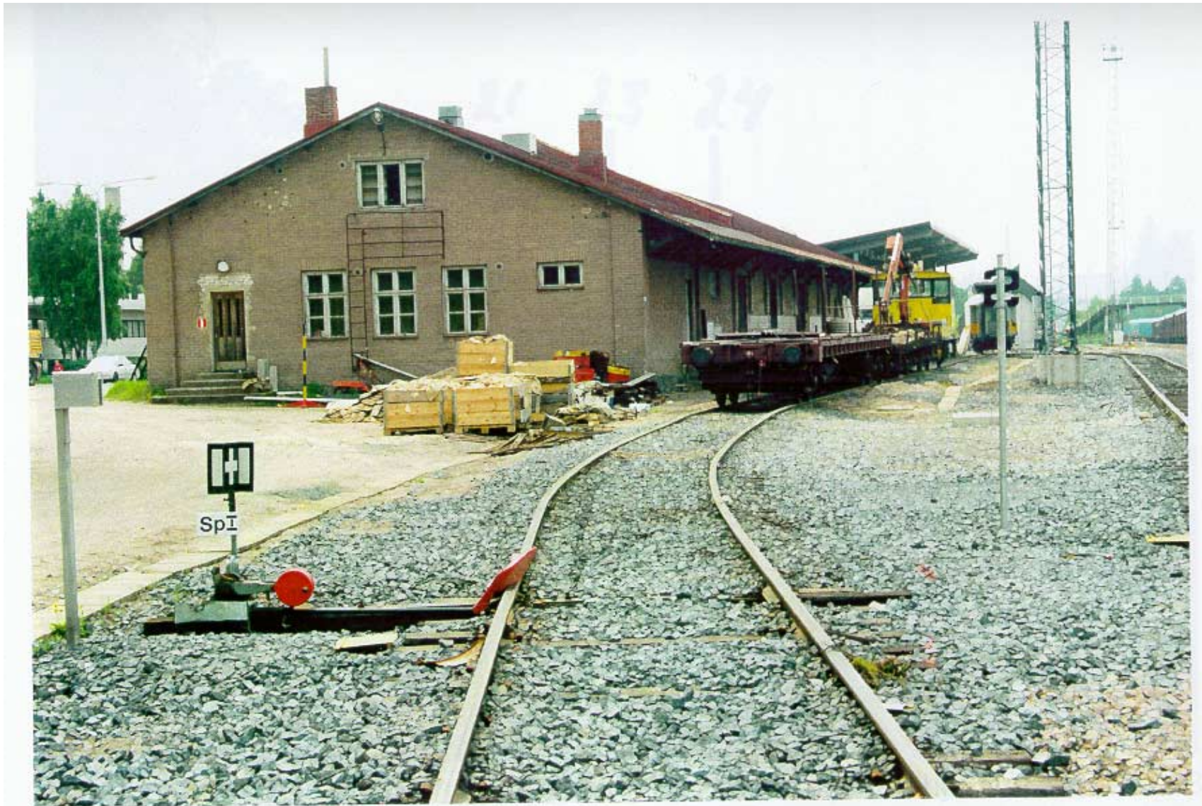
Ohjautuusi Raiteen 21 raiteensulku kiinni-asennossa. Ohjautui raiteelle 21.
