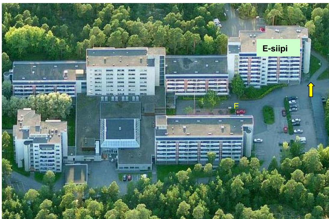
Kuva 1. Asuin- ja palvelukeskus. Palvelukeskus on rakennuskokonaisuuden matalimmassa osassa. Palokunta teki sammutushyökkäyksen nuolen osoittamasta uloskäytävästä. (Kuva: © Blom 2010)
