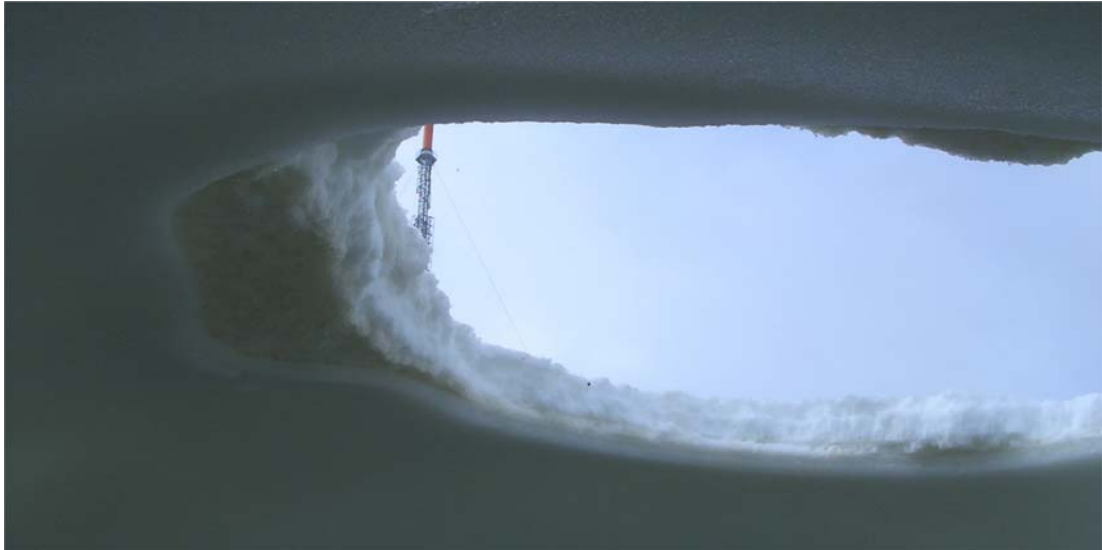
Kuva 2. Sortumakohta sisältä kuvattuna 15:27 (Kuva: Oulu-Koillismaan pelastuslaitos)
