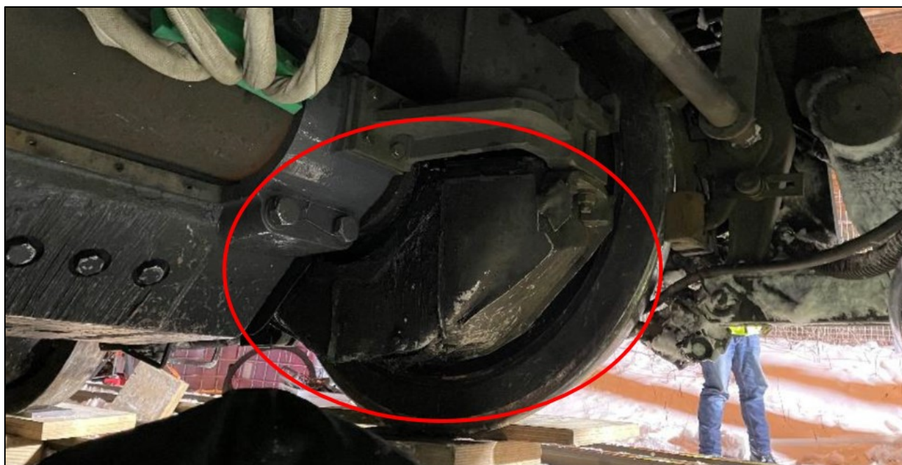
Kuva 9. Veturin akselinkäyttölaitteiden koteloita jouduttiin poistamaan. (Kuva: Väylävirasto, Merkinnät: OTKES)
