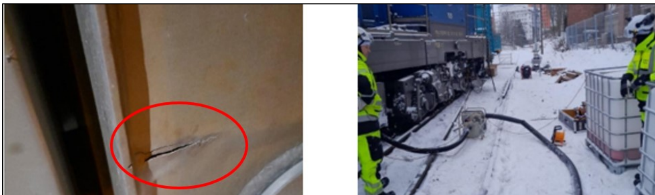
Kuva 7. Polttoainesäiliössä havaittiin murtuman kaltainen vaurio. Pois siirrettävän polttoaineen määräksi arvioitiin noin 2000 litraa. (Kuvat: Väylävirasto, Merkinnät: OTKES)
