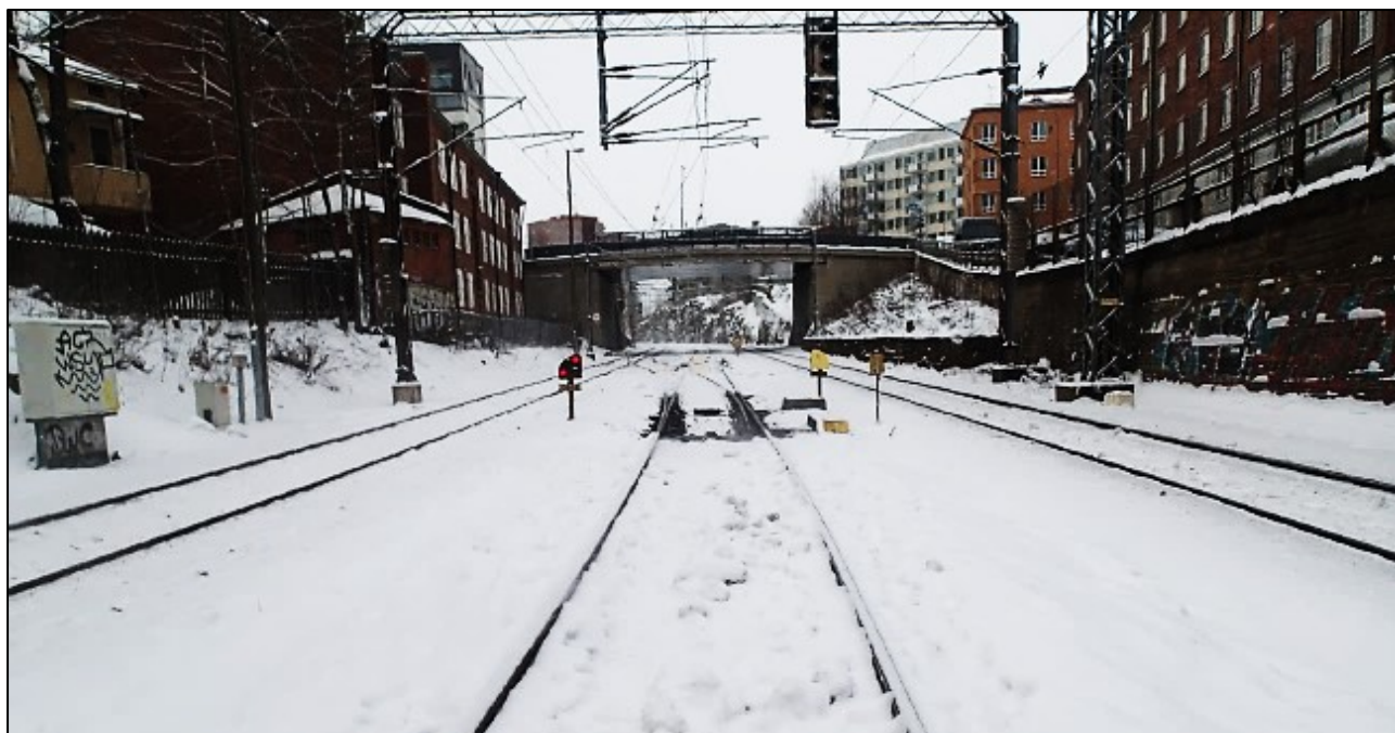
Kuva 19. Kuva vaihteesta V171 junan T7121 tulosuunnasta katsottuna. Suistunut veturi oli kulkemassa vaihteesta vasemmalle siirtyäkseen Lielähteen johtavalle läntiselle raiteelle. Kuvassa vaihde on eri asennossa kuin onnettomuushetkellä. (Kuva: OTKES)
