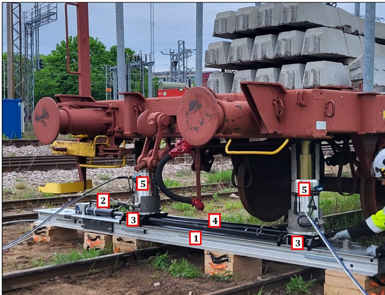
Kuva 6. Esimerkkikuva raivauksessa käytetystä tunkkikalustosta. Kuvassa sivuttaissiirtopalkki (1), sivuttaissiirtotunkki (2), siirtokelkat (3), välitangot (4) ja nostotunkit (5). Nostotunkit on sijoitettu välitangoilla toisiinsa yhdistettyjen siirtokelkkojen päälle. Kiskoille nostettaessa suistunut kalusto nostetaan tunkeilla ylös, siirretään sivuttaissiirtotunkilla kiskojen kohdalle ja lasketaan alas. Kalustoa voidaan siirtää sivuttaissiirtotunkilla vain kymmeniä senttejä kerrallaan. (Kuva: Väylävirasto, Merkinnät: OTKES)
