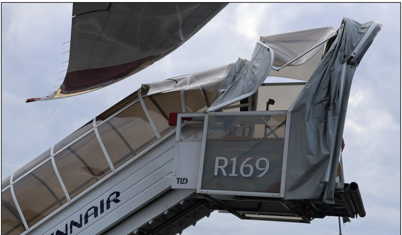
Kuva 3. Vaurioituneet portaiden katosrakenteet. (Kuva: OTKES)
