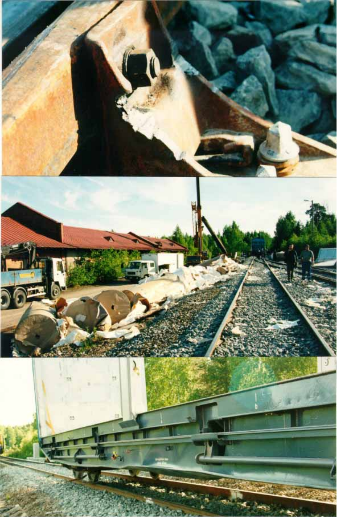
Kuva 3. Juna jatkoi matkaa, koska veturinkuljettaja ei voinut huomata yhden vaunun telin suistuneen kiskoilta. Suistunut vaunu joutui toiseen vaihteeseen, jolloin sen piti ylittää risteävät kiskot. Tällöin vaunu kallistui voimakkaasti ja vaunun reunalaippa jäi hetkeksi viereisen radan kiskojen kiinnitysrakenteiden väliin. Kallistuneen vaunun paperikuorma mursi vaunun katteet ja kuorma putosi ratapenkereelle. Myös vaunun runko vääntyi (Nokia 9.6.1996).
