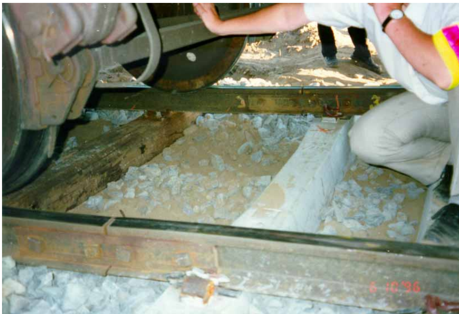
Kuva 8. Tilapäisessä kiilarakenteessa oli liian jyrkkä nousu ja puutteellinen sivuttaistuenta. Tilapäisrakenteen kohdalla puuratapölkyt siirtyivät jopa 15 cm sivusuunnassa. Samanaikaisesti uudet betoniratapölkyt pysyivät paremmin paikallaan, jolloin rataan syntyi mutka (Pieksämäki 10.6.1996).
