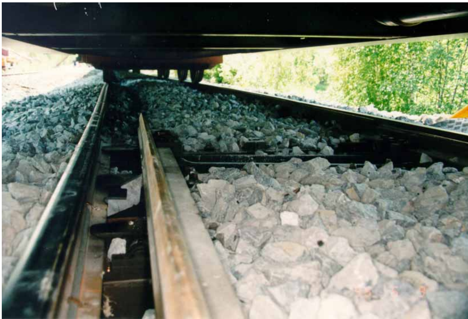
Kuva 2. Vaunun teli suistui vaihteen kohdalla radan oikealle puolelle. Vaihteen jälkeen oikeanpuoleiset kiskot olivat lyhyellä matkalla yli kuusi senttimetriä alempana kuin oikeanpuoleiset kiskot silloin, kun rata oli kuormitettuna. Kun juna ei kuormittanut kiskoja, kyseinen kiskon painuma poistui (Nokia 9.6.1996).
