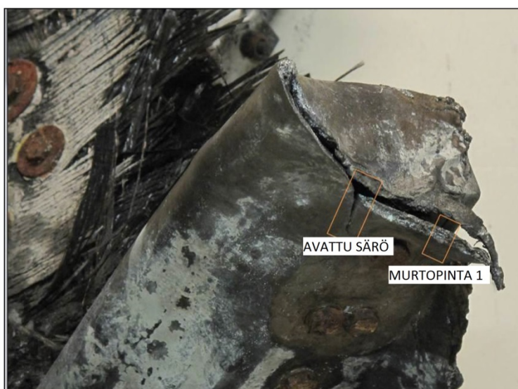
Kuva 14. Materiaalitutkimuksen yhteydessä leikattiin näytepalat murtopinnasta ja säröstä. (Kuva: VTT.)
