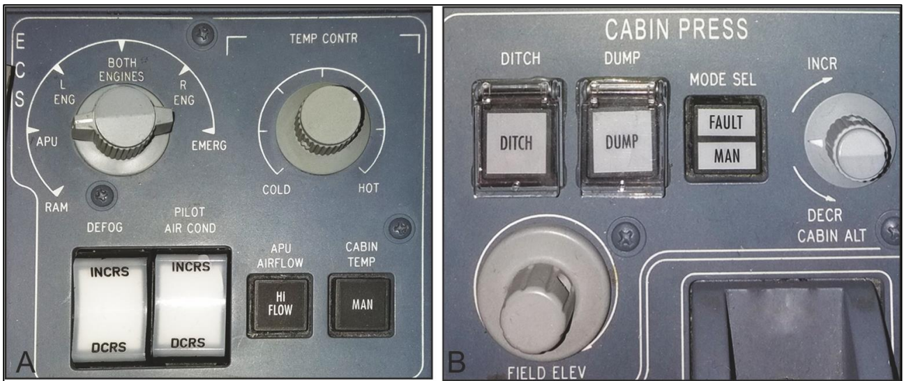
Kuva 4. 4A: ECS-ohjauspaneeli, jossa vuodatusilma valittuna apuvoimalaitteelta ja lämpötilan säädin noin kello yhdessä. 4B: matkustamon paineistuksen ohjauspaneeli. (Kuvat: OTKES)
