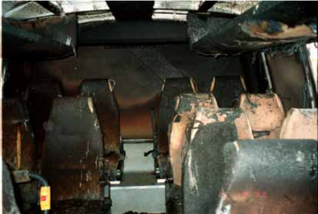
Kuva 13. Palon vaurioittamaa bussin takaosaa. Muun muassa katon lämpöeristettä on sulanut ja palanut.
