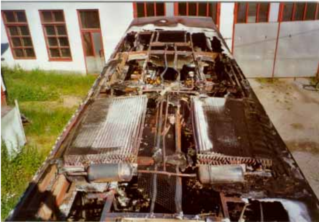
Kuva 3. Auton palanut katto. Kuvassa keskellä ilmastointilaitteen jäännökset.
