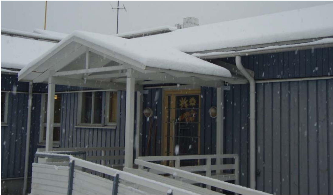
Kuva 40. Päiväkodin vaurioitunut kuisti korjausten jälkeen.
