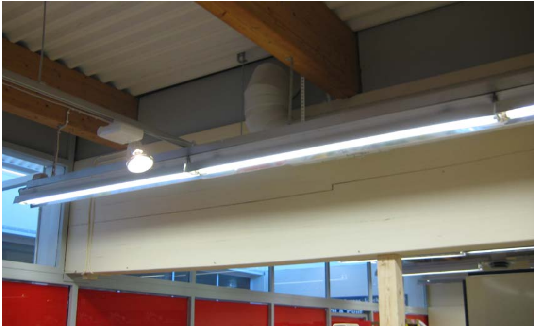
Kuva 38. Haljennutta palkkia tuettiin tukipilarilla. (Kuva: Mikael Lindberg.)
