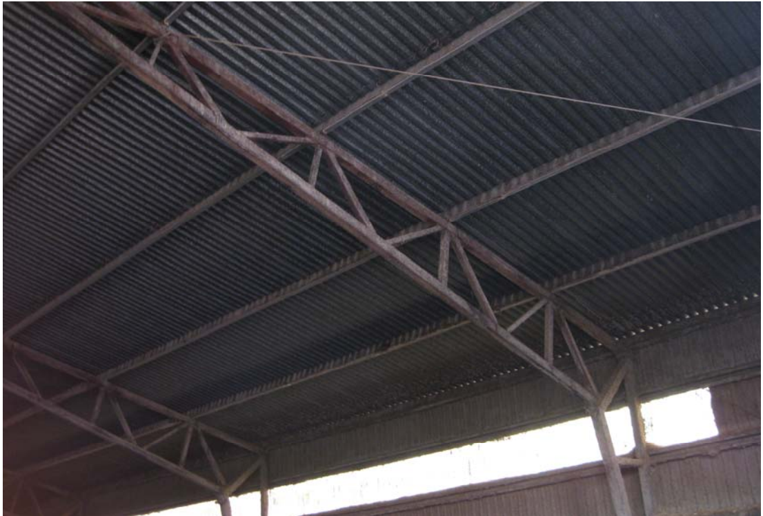
Kuva 28. Lähinnä ulkoseinää oleva pääkannattaja ja siihen kiinnittyvä katon jäykistysvaijeri.
