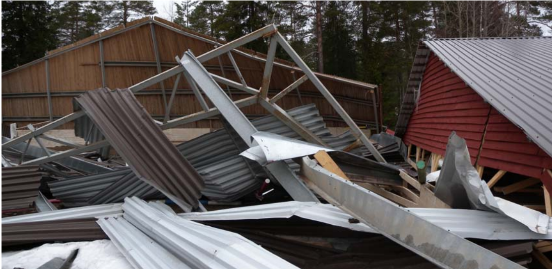
Kuva 29. Ehjänä säilynyt ristikon katto-osan ja seinäosan liitos.
