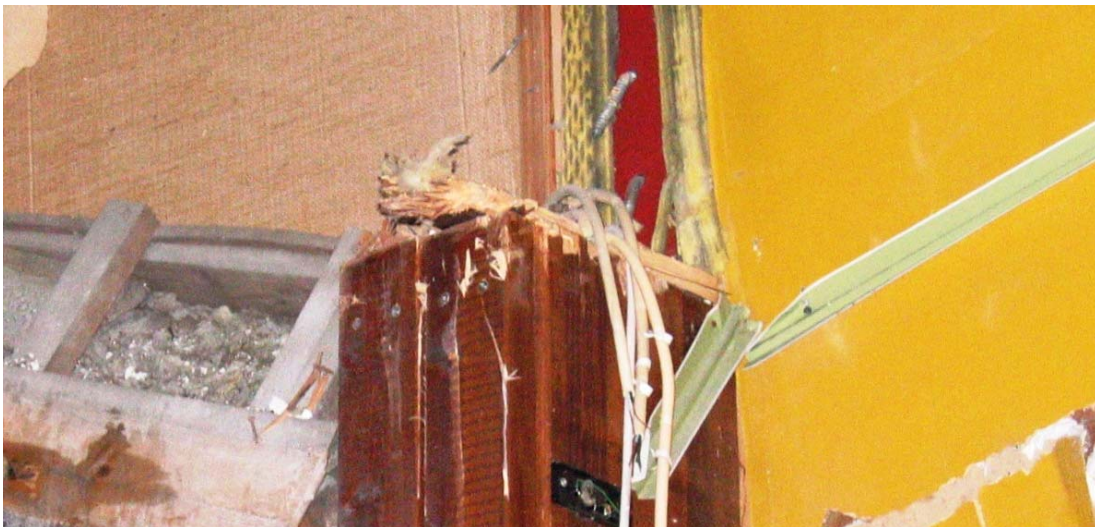
Kuva 21. Pudonnut palkki oli tuettu kuvassa näkyvän puupilarin päälle. (Kuva: poliisi.) Bild 21. Den balk som hade fallit bars upp av den träpelare som bilden visar. Picture 21. The dislodged beam was supported by the wooden pillar shown in the photograph.
