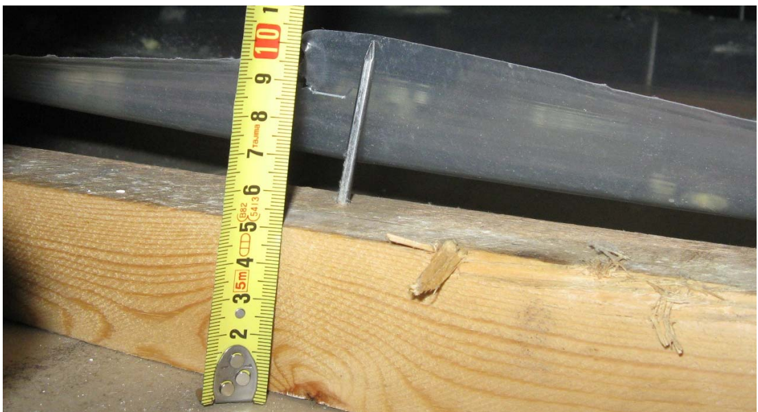
Kuva 3. Rimat 50 mm x 50 mm (k400) oli kiinnitetty kattoristikoiden alapaarteeseen 100 mm:n kirkailla käsin naulattavilla lankanuloilla, joiden tunkeuma alapaarteeseen oli 50 mm.
