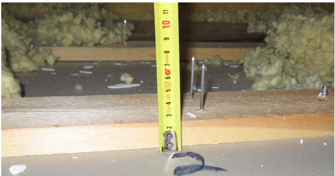
Kuva 6. Ruodelaudat 20–24 mm x 100 mm (k400) oli kiinnitetty kattoristikoiden alapaarteeseen kahdella 60 mm:n konenaulalla, joiden tunkeuma alapaarteeseen oli enintään 40 mm.
