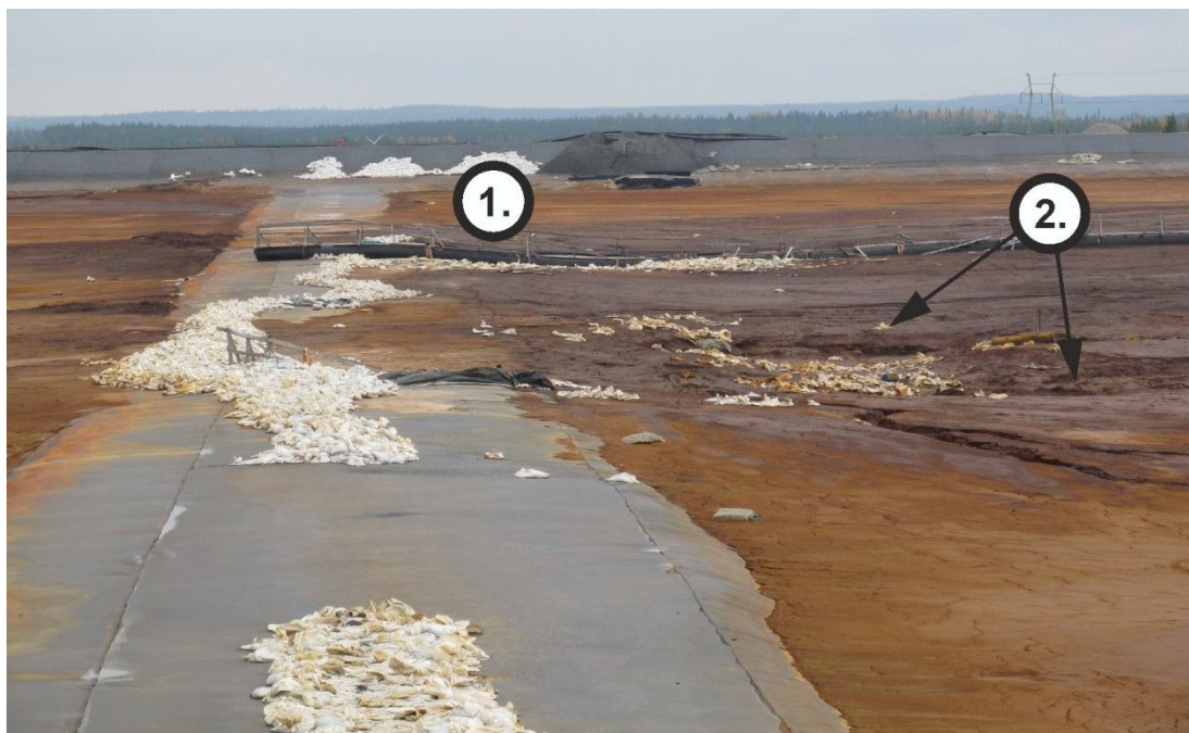
Kuva 4. Myöhemmin havaitut uudet vuotokohdat. Kuvassa: 1 = alkuperäinen vuotokohda ja 2 = myöhemmin paikallistetut vuotokohdat.
