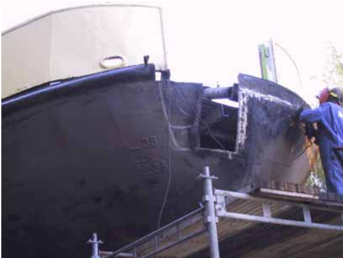
Kuva 6. Peräosan vaurioitunut alue. Vaurioitunut törmäyslista on poistettu.
