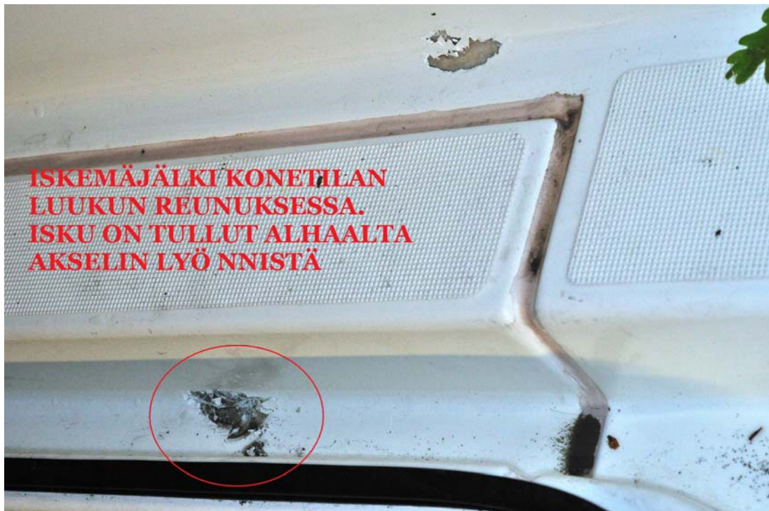
Kuva 23. Iskemäjälki konetilan luukun yläpuolella akselin pään osuttua konetilan luukun reunan alapuolelle.
