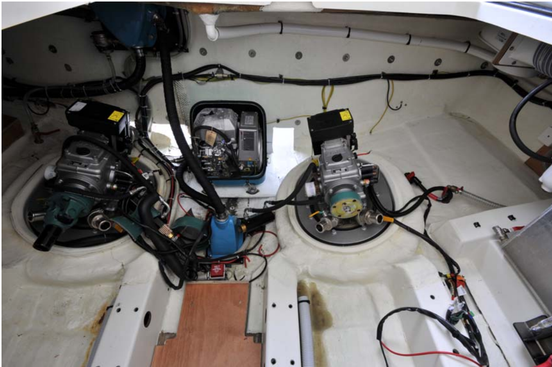
Kuva 3. Pohjapalkiston peräosa on korvattu Volvo Pentan asennuskaivolla ja sen tukipalkeilla. Kuva on otettu moottoreiden irrotuksen ja konetilan puhdistuksen jälkeen.
