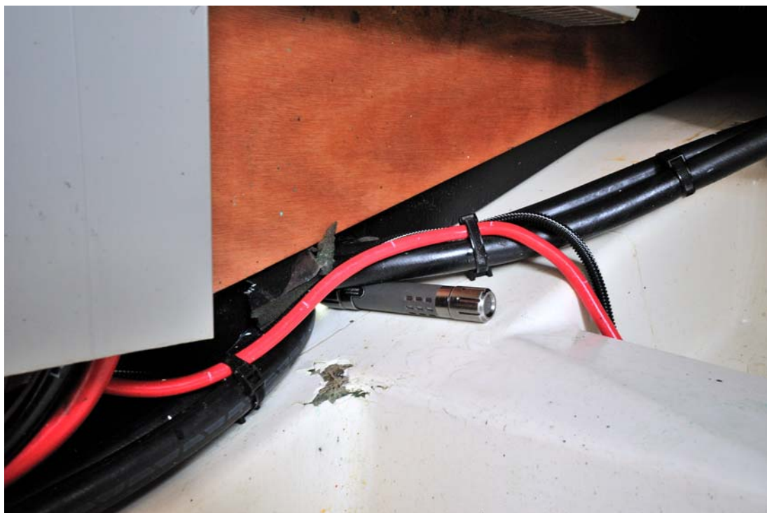
Kuva 36. Vanerilaipion ja lasikuiturakenteen välinen vaahtomuovilla täytetty rako palvelee letkujen ja kaapeleiden läpivientikohtana. Kuvassa laipion alta on esimerkin vuoksi työnnetty myös tutkijan käsivalaisin.
