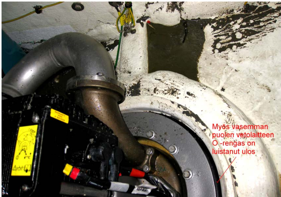
Kuva 28. Vasemman vetolaitteen O-rengas oli myös luiskahtanut ulos paikaltaan, vaikka vetolaitteeseen kohdistunut isku oli pienempi.
