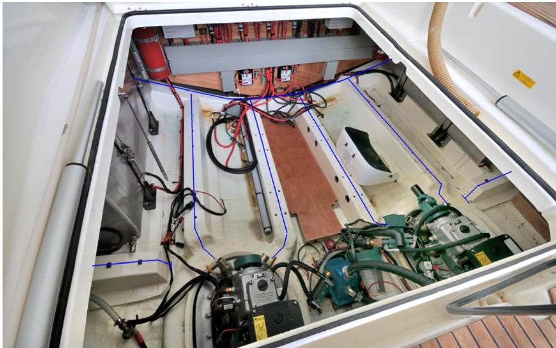
Kuva 29. Kuva konetilasta puhdistuksen ja moottoreiden poistamisen jälkeen. Sinisellä viivalla on osoitettu pohjapalkkien sijainti ja kohdat, missä ne on katkaistu ja liitetty asennusrenkaaseen. Liitokset oli laminoitu kiiltävän päälle ja sen lisäksi katkaisukohtiin muodostui lujuusopillisesti arveluttavia epäjatkuvuuksia, jotka heikentävät rakenteen.
