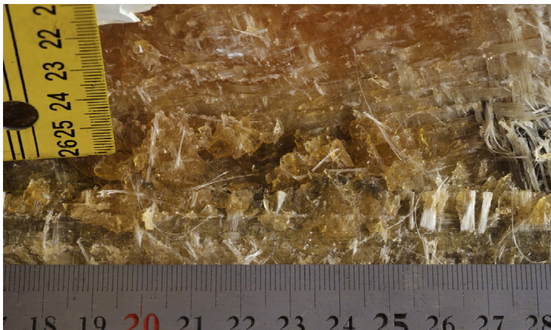
Kuva 15. Peräpeilin alakulman laminaattia veneen oikealta puolelta pohjan ja peräpeilin repeytymisalueelta. Kuvasta näkyy korkea hartsipitoisuus ja kudottujen kankaiden eli Rowing-kerrosten loppuminen välittömästi ennen kulmaa.
