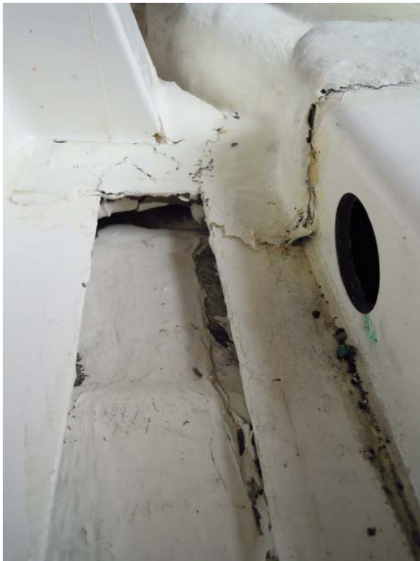
Kuva 5. Pohjapalkiston liitostapa runkoon. Palkisto ei kauttaaltaan ole ollut pohjassa kiinni. Sovitus on tehty liimakitillä.
