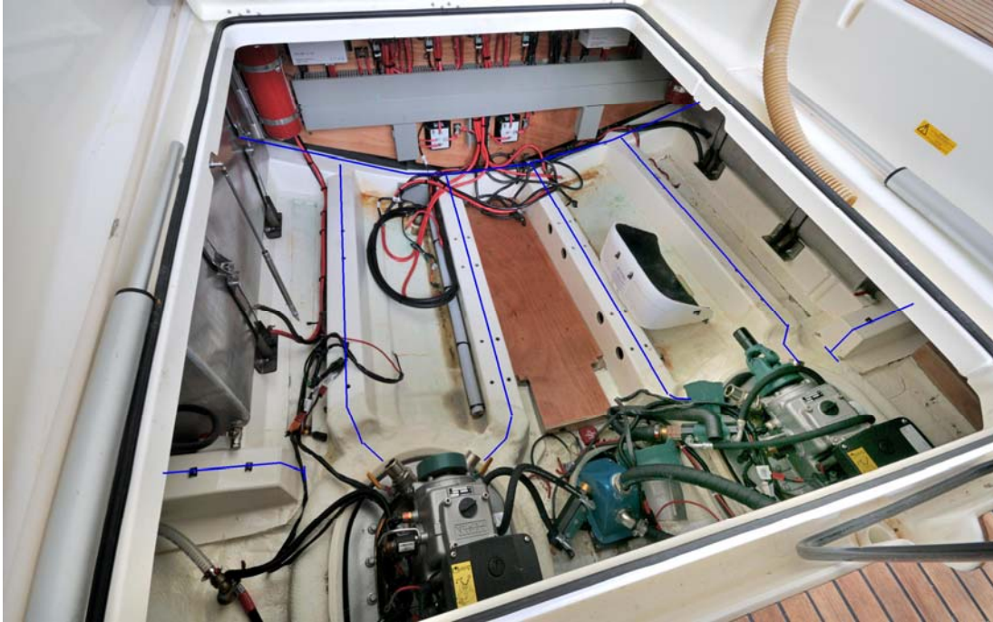
Kuva 25. Kuva konetilasta puhdistuksen ja moottoreiden poistamisen jälkeen. Sinisellä viivalla on osoitettu pohjapalkkien sijainti ja kohdat, missä ne on katkaistu ja liitetty asennusrenkaaseen. Liitokset oli laminoitu kiiltävän päälle ja sen lisäksi katkaisukohtiin muodostui lujuusopillisesti arveluttavia epäjatkuvuuksia, jotka heikentävät rakenteen.
