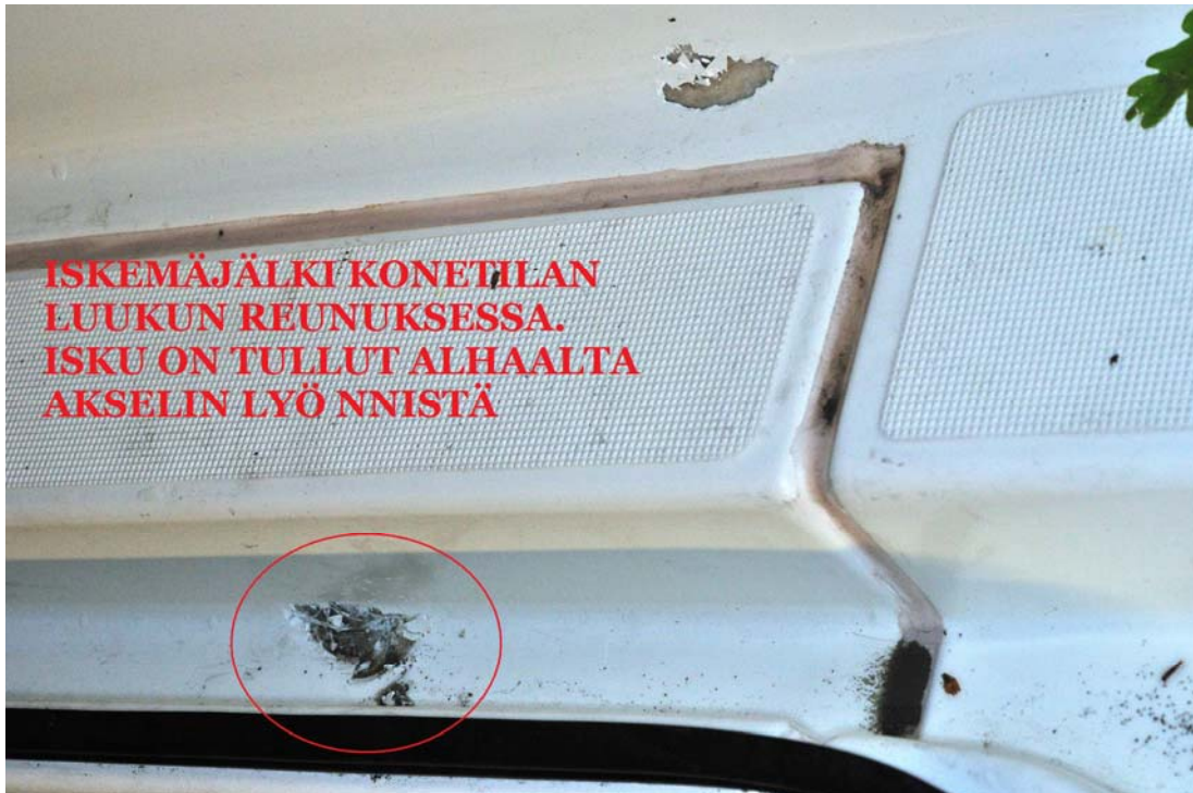
Kuva 19. Iskemäjälki konetilan luukun yläpuolella akselin pään osuttua konetilan luukun reunan alapuolelle.
