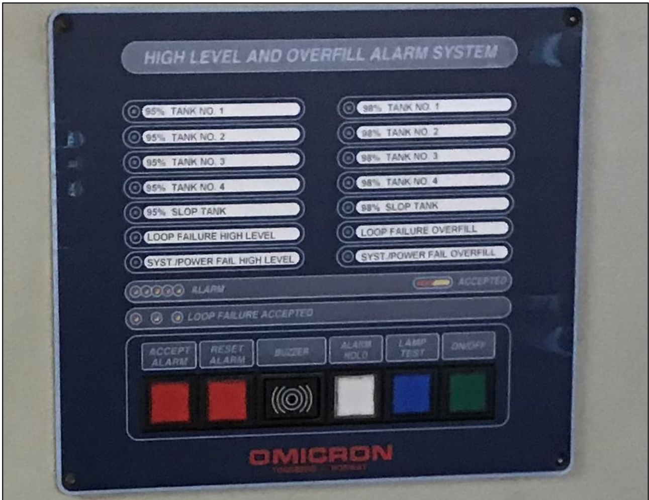
Kuva 7. Lastitankkien täytön hälytyspaneeli. (Kuva: OTKES)
