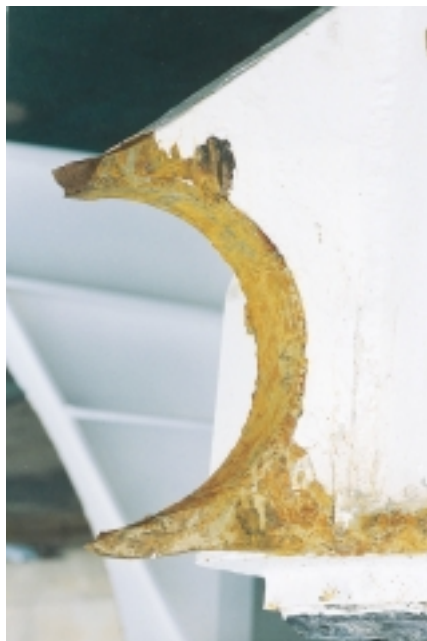
Kuva 8.22 Visiirin vasemmanpuoleisen saranan murtunut vasemmanpuoleinen korvake.
