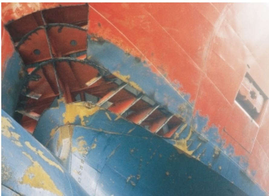
Kuva 3.12 Jäävaurioiden laajuus vuoden 1987 korjausten yhteydessä.
