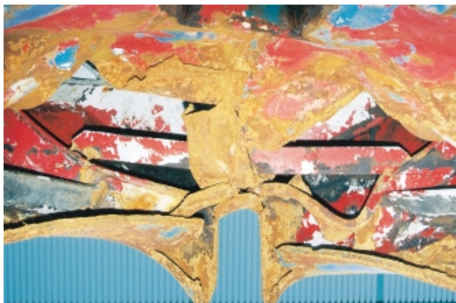
Kuva 8.6 Visiirin pohjalevyn vaurioita.
