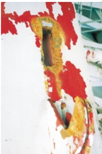
Kuva 8.19 Vasemmanpuoleisen sivulukon korvakkeen irtaamiseen liittynyt vaurio. Käsikäyttöisen lukon korvakkeet.
