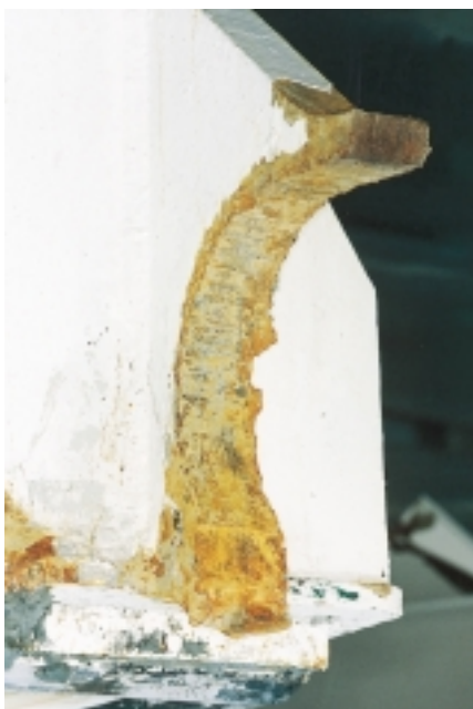
Kuva 8.24 Visiirin oikeanpuoleisen saranan murtunut oikeanpuoleinen korvake.
