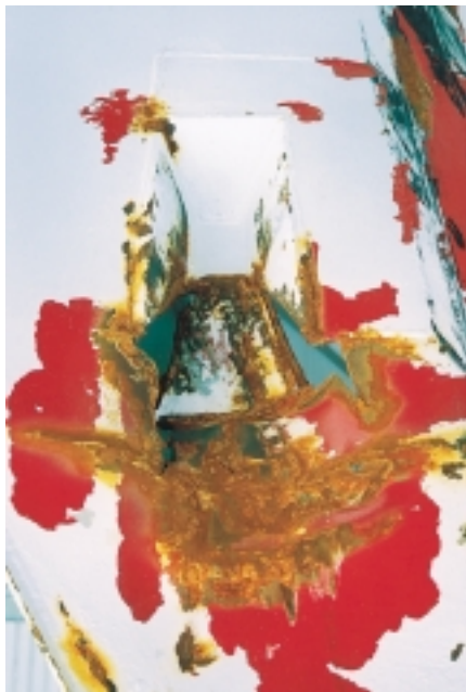
Kuva 8.8 Vasemmanpuoleisen ohjauskolon vaurioita.
