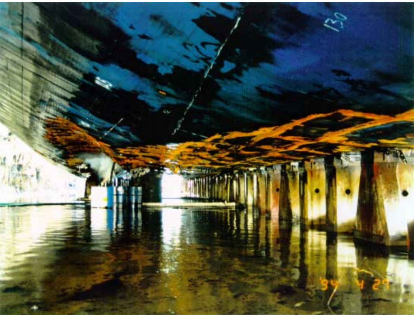
SALLY ALBATROSSin pohjan keskilinjän oikealla puolella olevia vaurioita Holvimaisen päävaurion alku näkyvissä kuvassa vasemmalla
