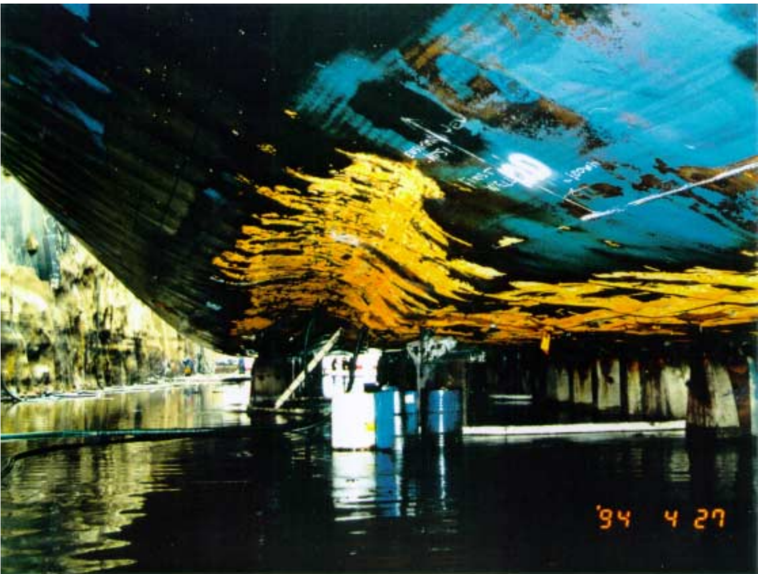
Päävaurion alkukohta pohjan oikeanpuoleisella sivustalla
