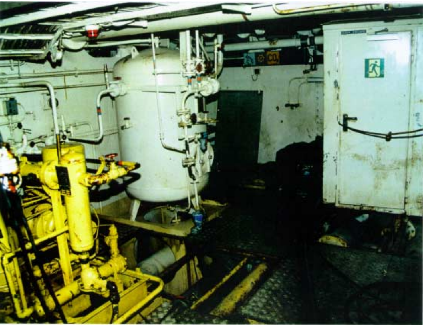
SALLY ALBATROSSin separaattorihuoneen lattia miesluukun kohdalta avattuna
