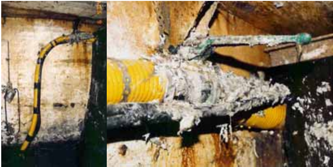
Bild 7. Avloppsrörets gång på bakre lastrummets akterskott. Till höger kulventilen i läget öppen. Ventilen har inte rengjorts efter bärgningen.
