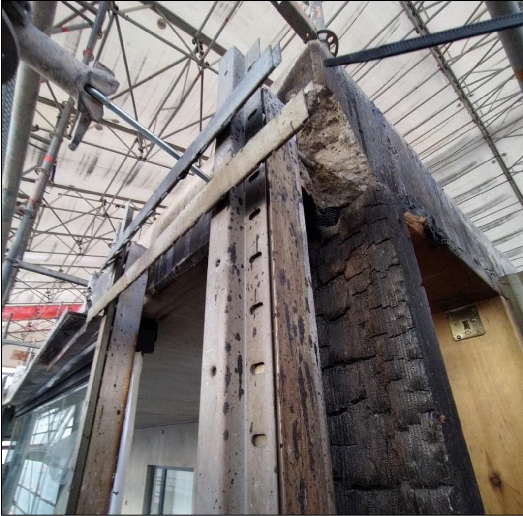
Kuva 24. Parvekeseinän pystyontelo avautui suoraan katto-onteloon. Parvekkeen päätyseinän puurunko on osallistunut paloon. (Kuva: OTKES)
