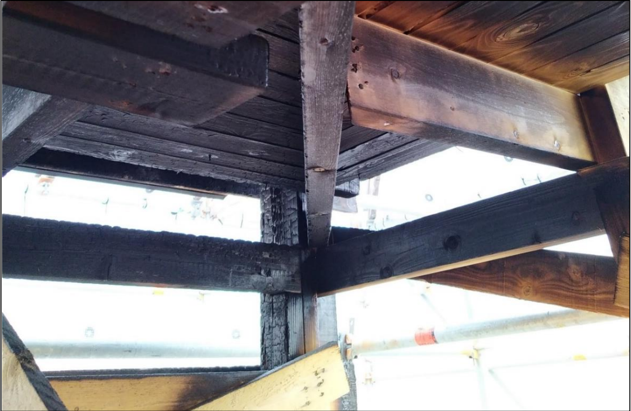
Kuva 32. Kuva vastakkaiselta puolelta kuin kuva 31. Palo oli ehtinyt leviämään B-osan katto-onteloon, kun se sammutettiin. (Kuva: OTKES)
