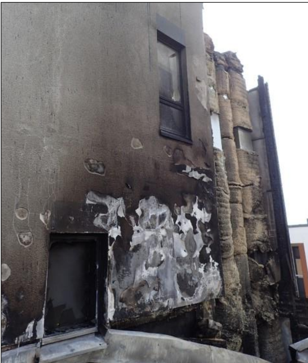
Kuva 27. Palo levisi kuvassa oikealla olevan rasvahormin roilon seinän syttyttyä ja rakenteen petettyä C-osan katto-onteloon. Kuvassa näkyy myös ikkuna, joka hajosi kattopalon seurauksena. (Kuva: OTKES)
