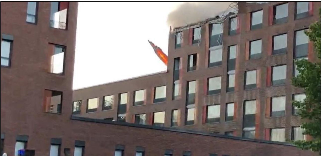
Kuva 9. Rasvahormien roilon seinä kaatui kello 22.22 palavana C-osan katolle. (Kuva: Stofix Oy)
