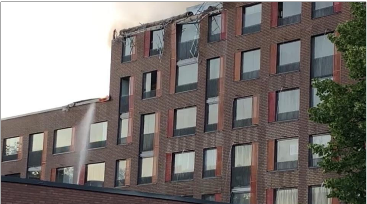
Kuva 10. C-osan katolle kaatunutta seinärakennetta yritettiin sammuttaa alemmalta tasolta käsin. (Kuva: Stofix Oy)
