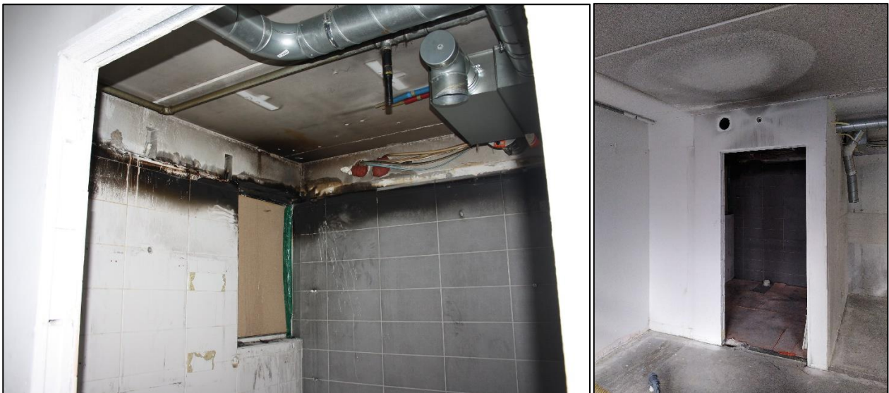
Kuva 29. Kylpyhuoneen (vasemmalla) ja olohuoneen (oikealla) sprinklerisuuttimet laukesivat palon levittyä C-osan katosta ikkunan kautta asuntoon (Kuvat: OTKES)
