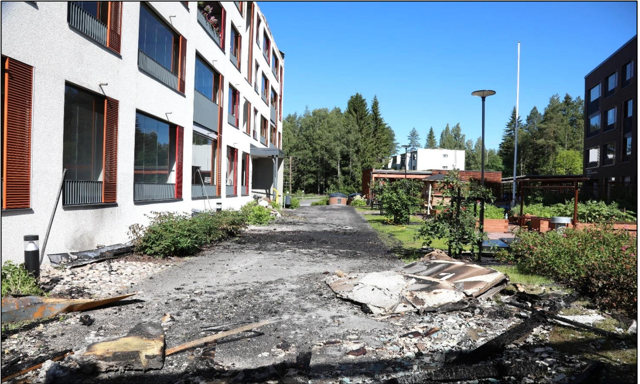
Kuva 17. Kuvassa D- ja C-portaan sisäpiha. Taustalla näkyvälle katokselle siirrettiin asukkaita pelastushenkilöstön avustamina. Etualalla katolta pudonnutta palojätettä. (Kuva: Poliisi)
