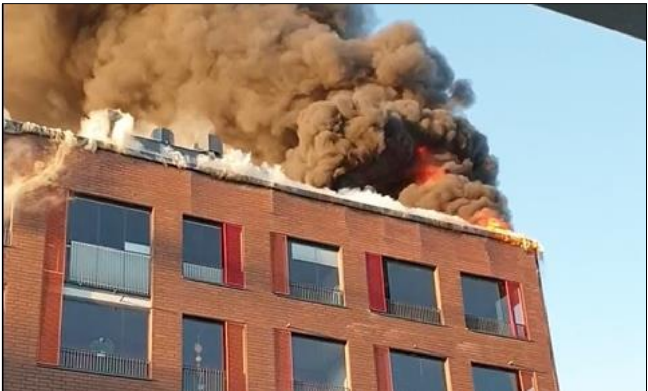
Kuva 3. D-talon räystääs B-talon suunnasta kuvattuna kello 21.42. Syttymisparveke on oikealla ylhäällä. (Kuvakaappaus silminnäkijän videolta)
