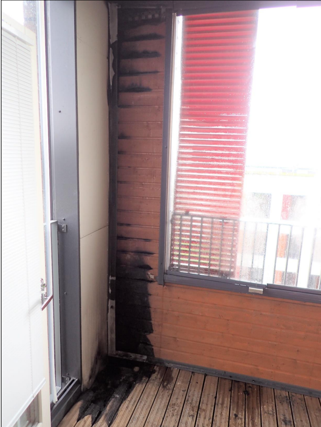
Kuva 22. Syttymispaikka parvekkeen vasemmassa ulkokulmassa lattianrajassa. Alkusammutus rajoitti paloa parvekkeella, mutta palo oli ehtinyt leviämään onteloihin. (Kuva: OTKES)
