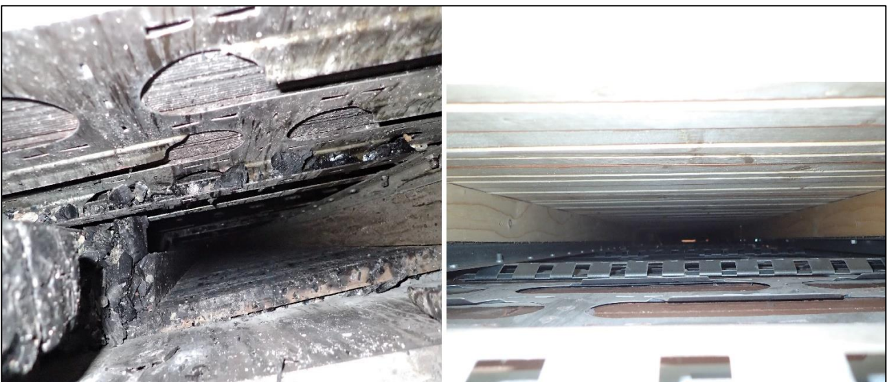
Kuva 25. Kuvat rakenteeseen muodostuneesta katkaisemattomasta 85 mm syvyysestä pystyontelosta. Palon aikana pystyonteloon putosi kekäleitä, joita näkyy myös kuvassa. (Kuvat: OTKES)
