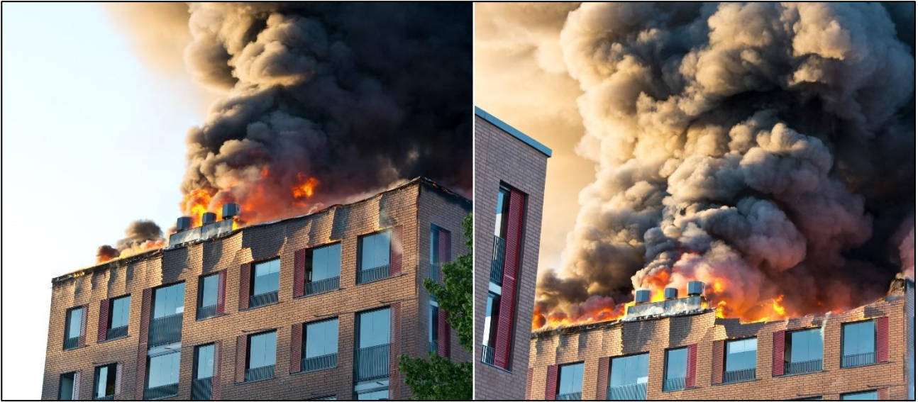
Kuva 6. Kuvassa D-osan julkisivun reunan murtuminen sisäänpäin noin kello 21.55. (Kuva: Color-kuva Oy)
