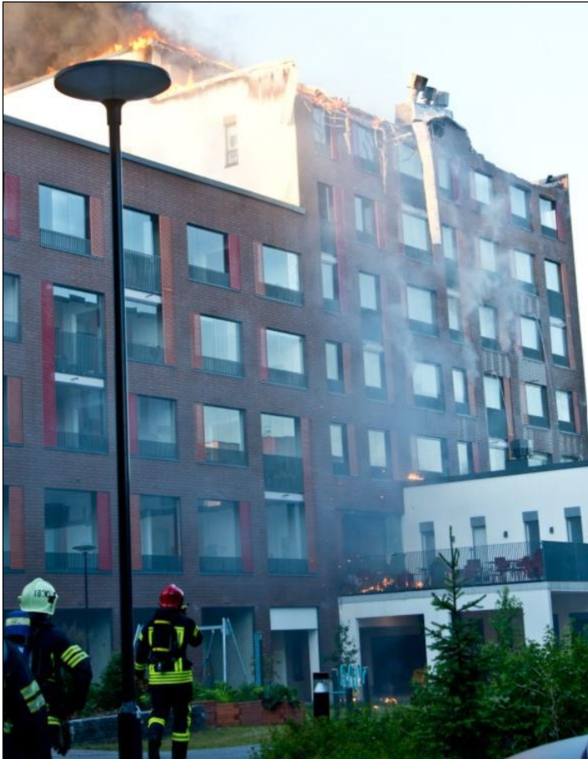
Kuva 8. D-osan katolta pudonneet materiaalit palavat G-osan katolla ja palvelukodin parvekkeella kello 22.05. RKS181 etenee kohti G-osaa. Rasvahormin roilon yläreuna palaa. (Kuva: Colorkuva Oy)
