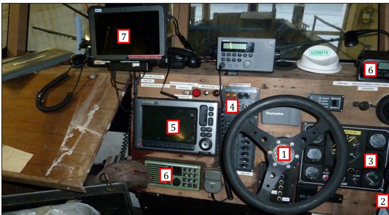
Bild 8. Båtens manöverpanel: (1) roder, (2) kontrollspakar (utanför bilden), (3) motorövervakningsmätare, (4) brytpaneler, bl.a. belysning och läns-pumpar, (5) radar/ekolod/kartplotter, (6) marina VHF-radiotelefoner, (7) PEKE-terminal. (Bild: OTKES)
