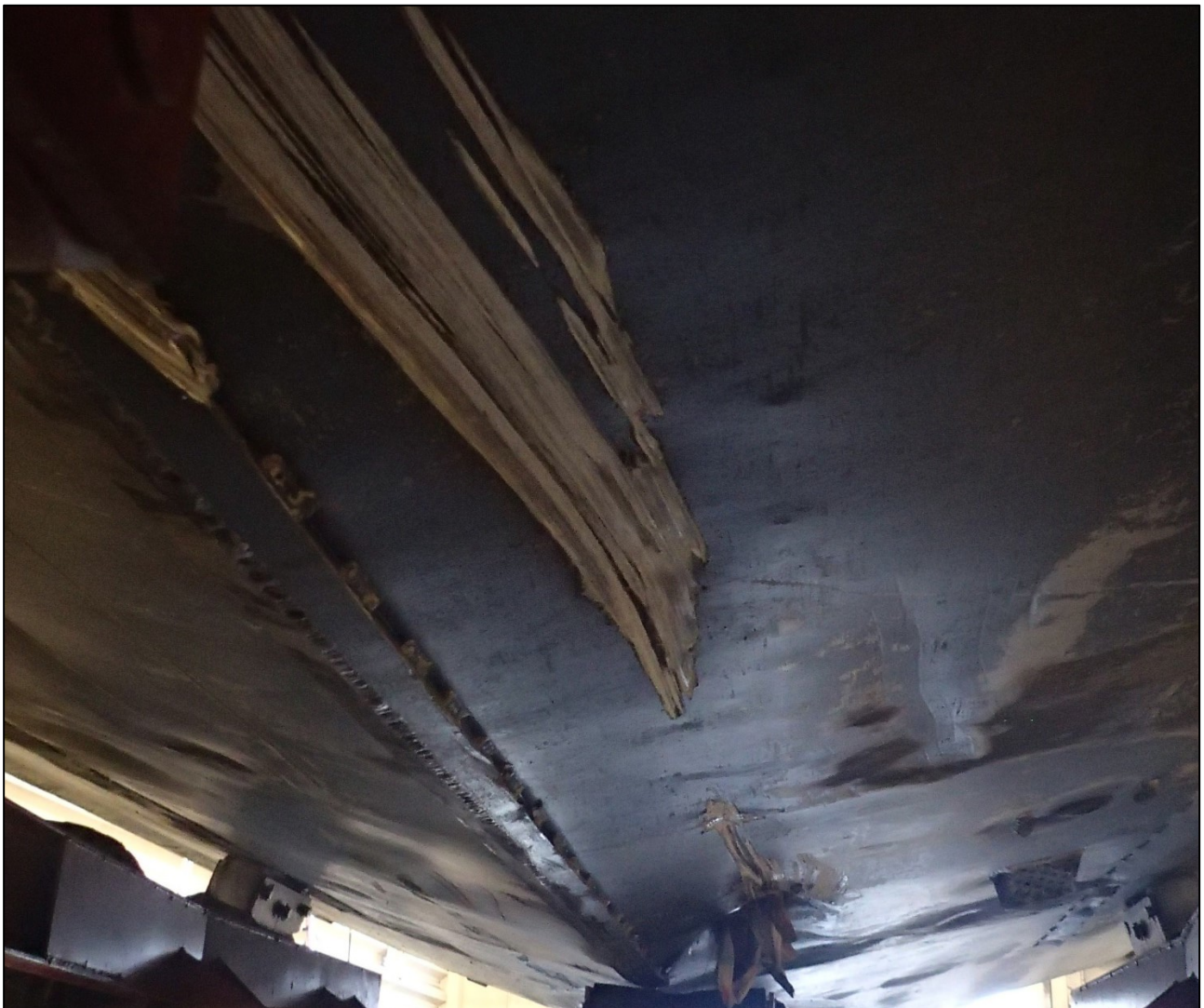
Bild 9. Spår av bottenkänningen i båtens botten på vänster sida om mittlinjen. Den första bottenkänningen har delvis träffat köllisten och orsakade inget läckage. Den andra bottenkänningen inträffade 0,2 m vänster om båtens mittlinje och trängde igenom båtens botten. Bild av båtens för i riktning mot aktern. (Bild: OTKES)
