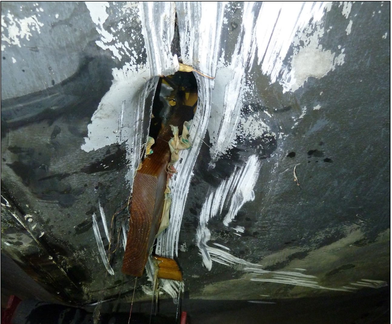
Bild 10. Den 0,6 m långa och som bredast 7 cm breda spricka som uppstod i båtens botten vid bottenkänningen samt skavmärkena som föregick sprickan. Hålet har lappats med träbitar och tyg inför bärgningen. (Bild: OTKES)
