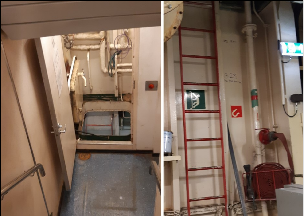
Kuva 13. På den vänstra bilden syns den öppna luckan till nödutgången som leder från AC-utrymmet till däck 2. På den högra bilden syns Ac-utrymmets utrymningsstege. (Bilder: Viking Line Abp)
