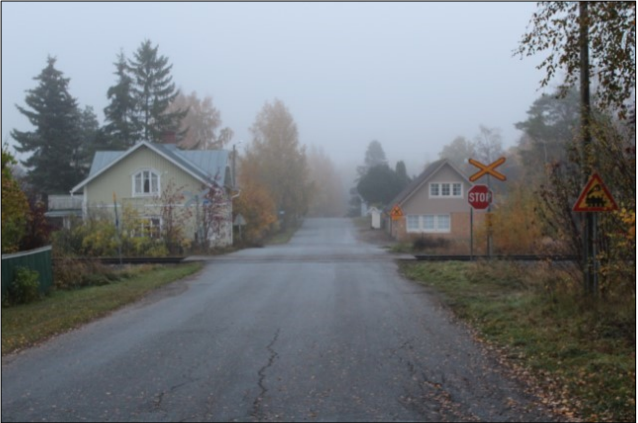
Kuva 10. Yleisilme tasoristeyksestä linja-auton tulosuunnasta. (Kuva: OTKES)
