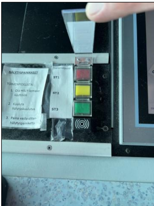
Kuva 1. Kuvassa on lennonjohdon käytössä olevat hälytyspainikkeet vaara- ja onnettomuustilantei- siin. (Kuva: ANS-Finland)
