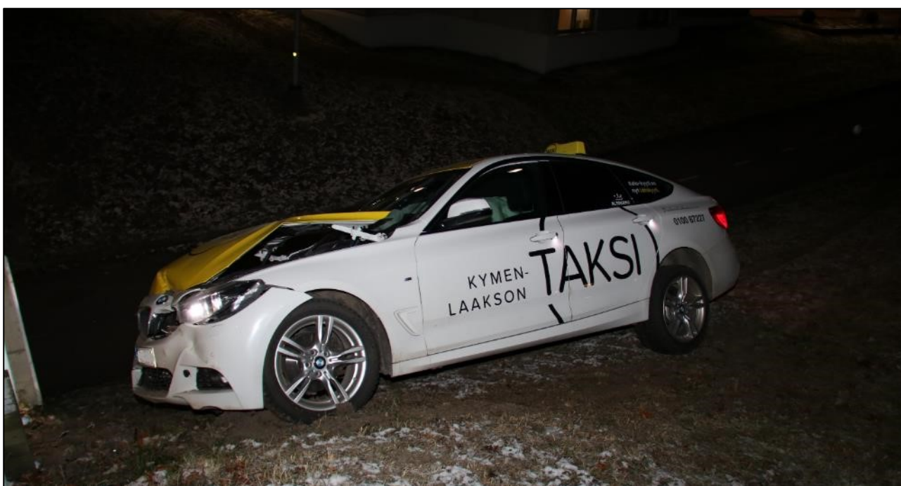
Kuva 49. Siltarakenteisiin törmännyt taksiauto. (Kuva: poliisi)
