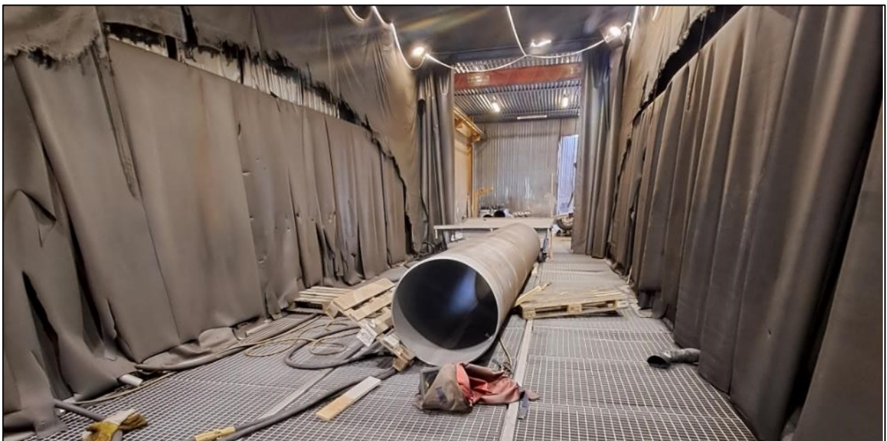
Kuva 44. Onnettomuustilanteessa käsittelyssä ollut putki myöhemmin kuvattuna. (Kuva: OTKES)
