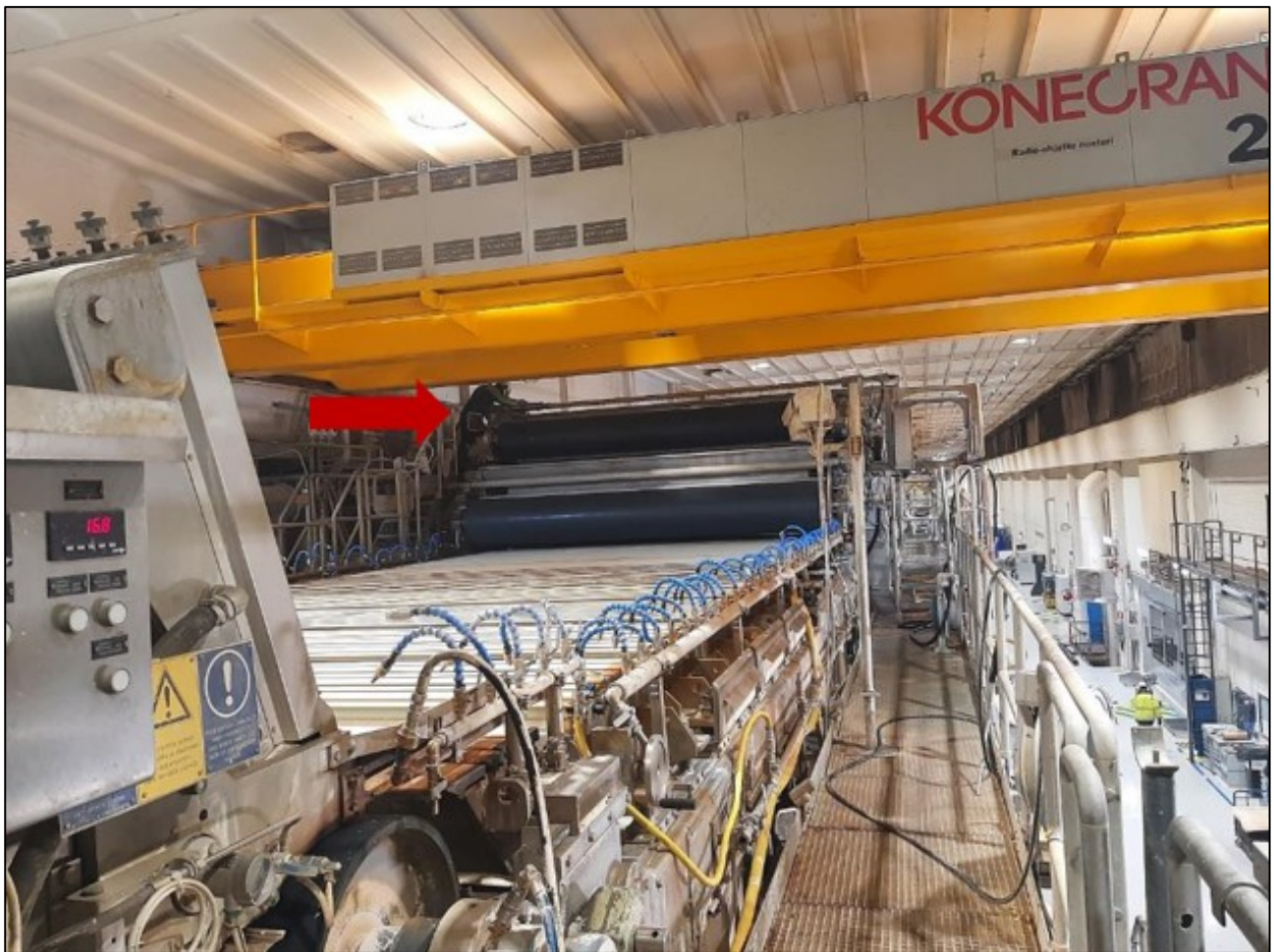
Kuva 14. Kartonkikone ja sen yläpuolella sijaitseva siltanosturi (oranssi). Punainen nuoli osoittaa paikkaa, jossa uhri työskenteli tapahtumahetkellä. Siltanosturin turvapainike jää kuvan oikean alareunan ulkopuolelle. (Kuva: OTKES)
