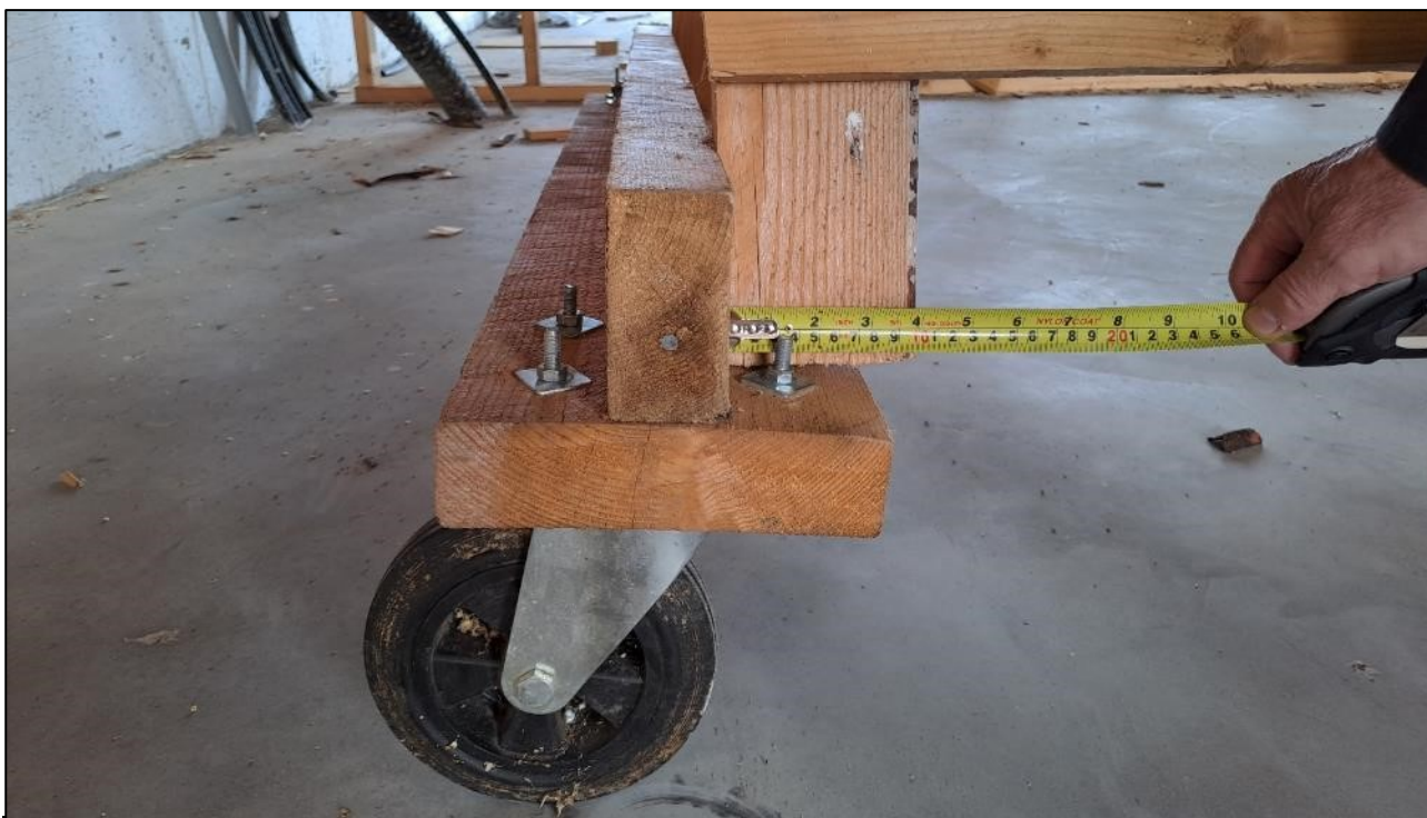
Kuva 35. Telinepukin alle asennettu pyörä. Telineen paino ei kohdistu suoraan pyörän päälle (Kuva: OTKES)
